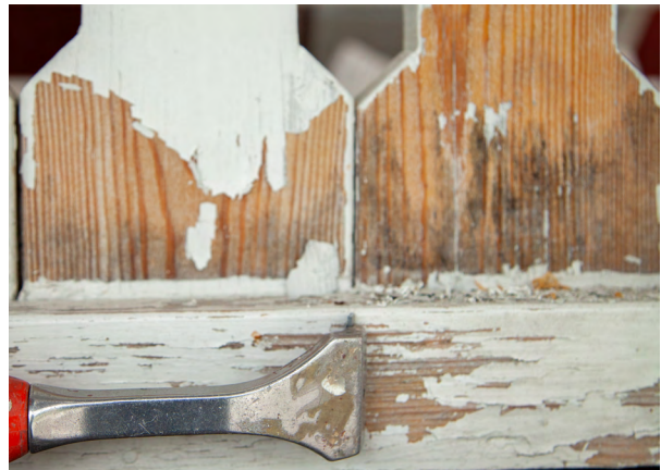
Kuva 12: Helposti pohjasta irtoava maali skrapataan pois mekaanisesti. Varo vahingoittamasta profiilien muotoja.
