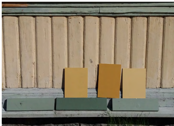
Kuva 10: Värimalleja kannattaa vertailla paikan päällä. Irralliset maalimallipalat on helppo siirtää eri puolille rakennusta, sillä valon suunta vaikuttaa väriin.
