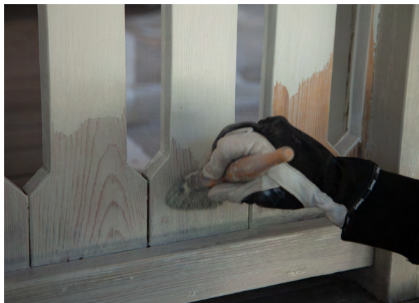
Kuva 15: Puupinnalle puhdistetut osat pohjamaalataan ohuesti. Vanhalle pellavaöljymaalinpinnalle erillistä pohjamaalauksia ei tarvita.
