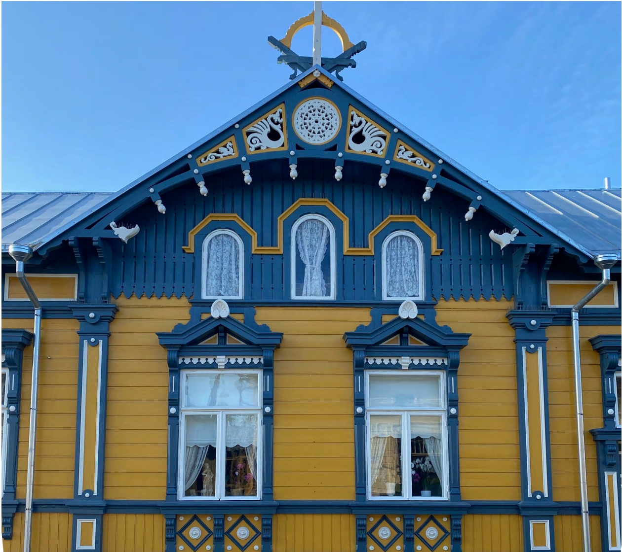
Kuva 1: Pellavaöljymaalilla maalattu talo Vanhassa Raumassa.
