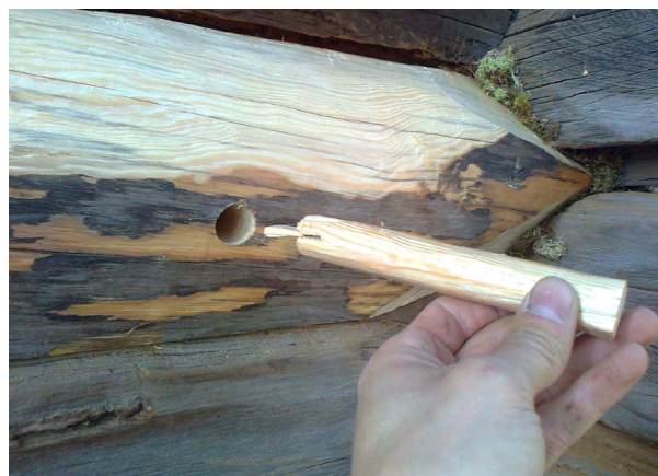
Kuva 17: Paikkapalan kiinnitys tapilla, jonka reiän sisään menevässä päässä on sen kiinnittymistä vahvistava kiila.
