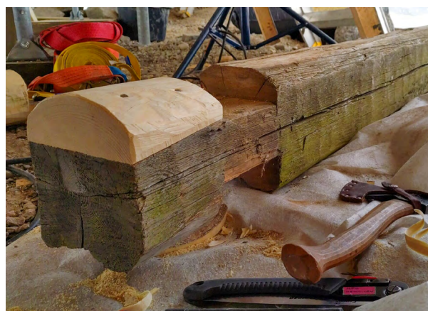
Kuva 18: Hirren pitkänurkan pään yläpinta paikattu lähinnä ulkonäöllisistä syistä. (Kuva: Restart Oy)
