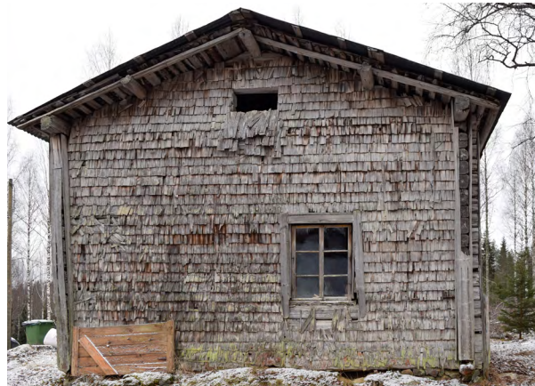
Kuva 16: Seinän suojaaminen päreillä.
