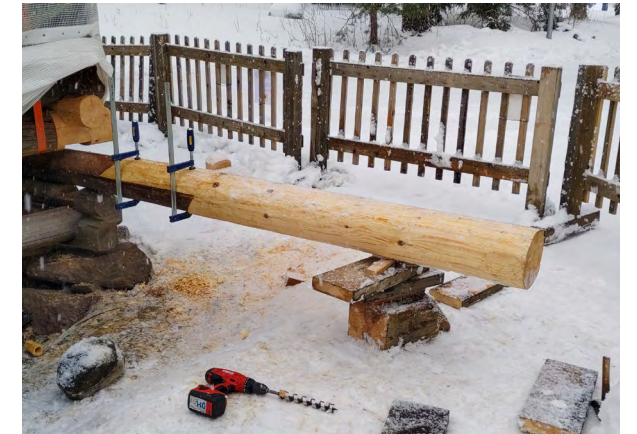
Kuva 19: Hirren pää on paikattu ja ulotettu riittävän pitkälle vanhaan hirteen, että siitä tulee rakenteellisesti kestävä. (Kuva: Restart Oy)
