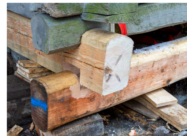
Kuva 26: Nurkkaliitoksen sovitus.
