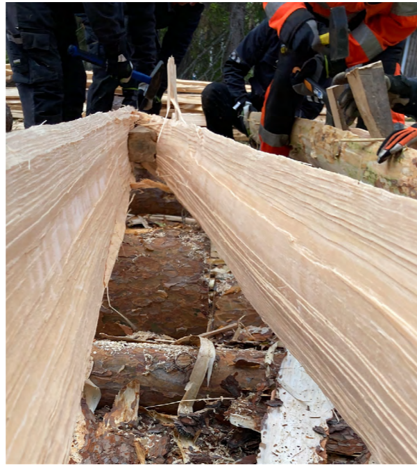
Kuva 22: Liisteen halkaisu kiiloilla ja kirveellä. (Kuva: Arkkitehtitoimisto Livady)
