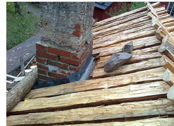
Kuva 34: Piipun yläpuolisten malkojen lisäpainona voidaan käyttää painokiviä.
