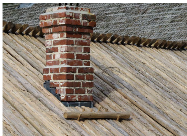
Kuva 33: Piipun alapuolisten malkojen kiinnitykseen voidaan käyttää lyhyttä painopuuta..
