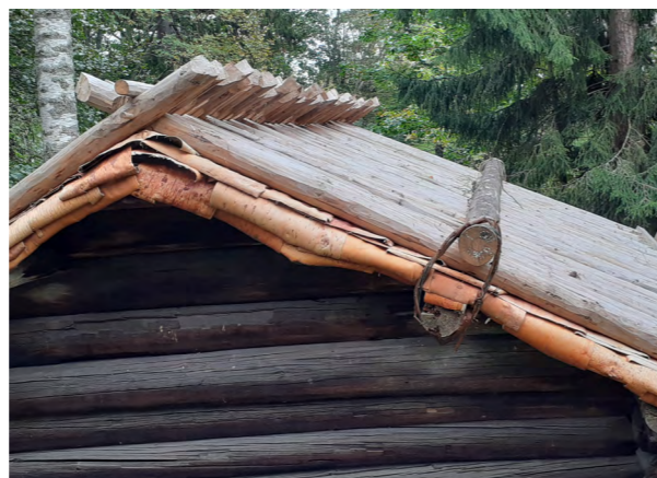
Kuva 32: Painopuun paikalla pysyminen voidaan varmistaa myös kiinnittämällä se vitsaksilla vuoliaisiin.
