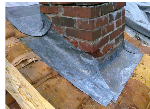
Kuva 35: Savupiipun juuri on suojattu neljästä lyijypellin palasta tehdyllä kauluksella.
