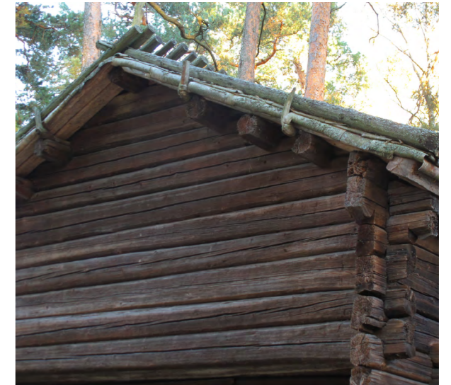
Kuva 29: Koukkupuut päätyräystäällä.
