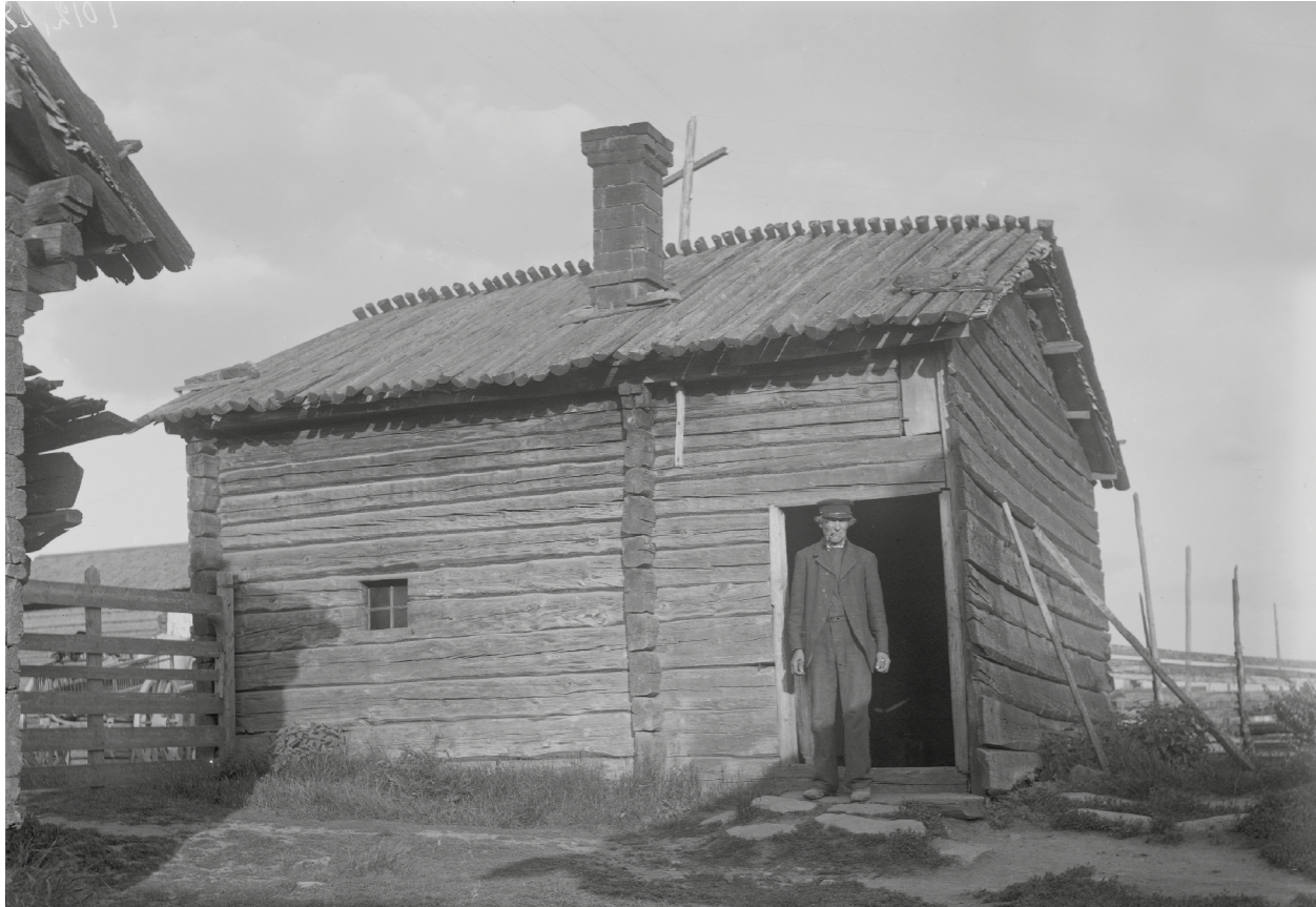
Kuva 5: Arkistokuva räystäspalkillisesta tuohi-malkakatosta.
