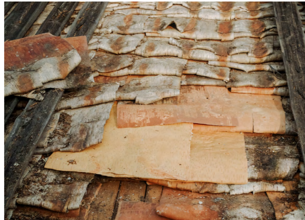
Kuva 14: Tuohialuskatteen paikkaaminen: Uudet tuohet limitetään vanhaan kateeseen.
