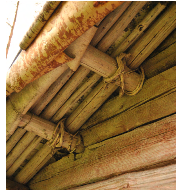
Kuva 25: Juurikoukku on kiinnitetty vitsaksella vuoliaisiin.
