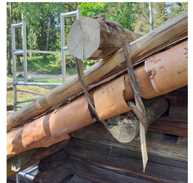
Kuva 30: Painopuun kiinnitys vitsaksella. Sidos on lisäksi varmistettu rautalangalla.
