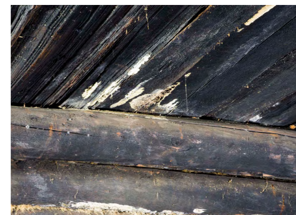
Kuva 13: Lahovaurio alusrakenteissa.
