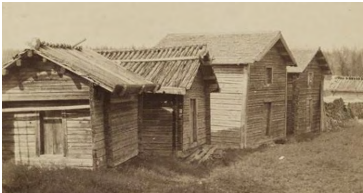
Kuva 7: Arkkitehti Yrjö Blomstedtin kuvaama aittarivi Kuhmosta vuodelta 1894, tuolloin 1880-luvulla rakennetut uudemmat aitat on katettu jo päreillä. Vanhemmissa aitoissa on yhä räystäslankulliset malkakatot. Taaemmassa tuohi-malkakatossa on käytetty painopuiden kiinnitykseen reikälautaa.
