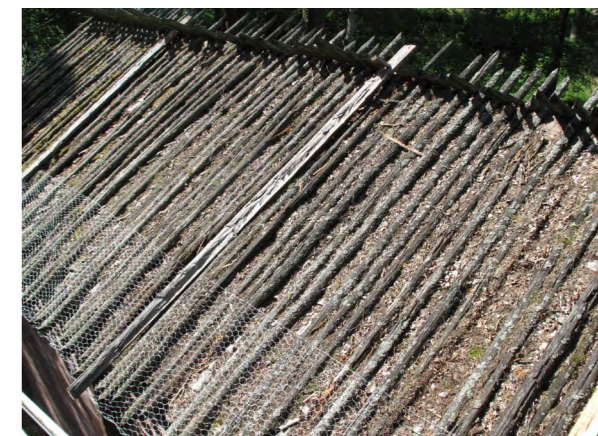
Kuva 12: Väliaikaisilla maloilla tuettu verkko estää lahonneen materiaalin putoamista katolta ennen korjaustöitä.
