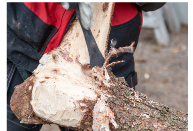
Kuva 21: Juurikoukun räystäällä näkyvältä osuudelta kuori poistetaan tylpällä työkalulla vaingoittamatta puun pintaa.
