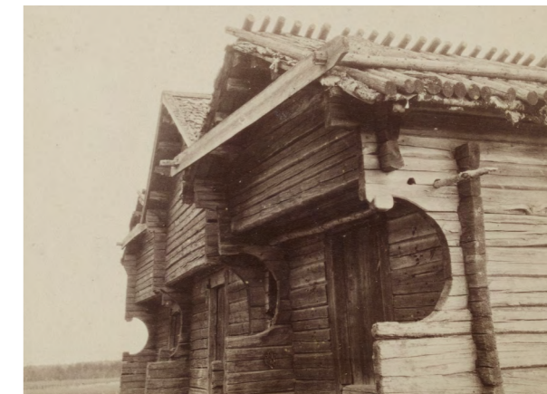
Kuva 8: Paltamolaisessa aitassa painopuut on kiinnitetty toisiinsa solkilankulla.
