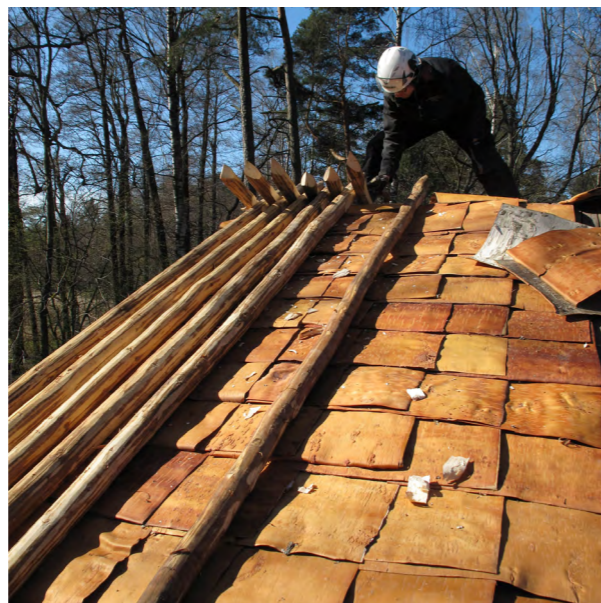
Kuva 28: Malkojen asettelua tuohien päälle räystäslankullisessa katoissa. Joskus malkojen risteämiskohdan ohennusta voidaan vielä veistää katolla, jotta malat asettuvat toisiaan vasten.
