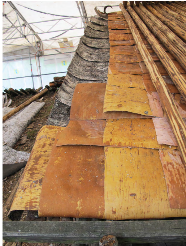
Kuva 27: Tuohien yksi mahdollinen ladontamalli päätyräystäällä. Myös muita ladontamalleja on olemassa. Tärkeintä on huomioida, että tuohien kerrosmäärä pysyy samana kuin muussa kateessa.
