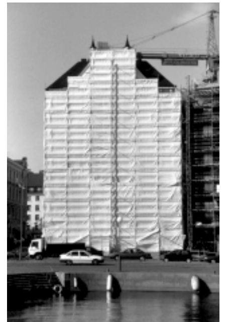
Kuva 13. Asiallisesti suojattu rappaus työmaa. Rappaus töiden onnistumiseen vaikuttavat huomattavasti alustan etukäteiskasteleminen, hallittu rappauskerrosten kuivuminen ja muutaman vuorokauden mittainen jälkikostutus. Suojauksella on tässä tärkeä tehtävä.
