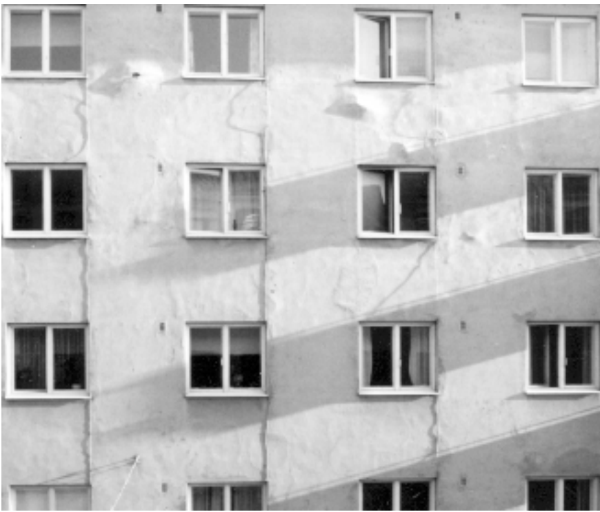
Kuva 4. Julkisivun kuntokartoituksessa tärkeimpiä alueita ovat:
