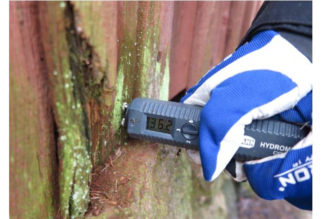
Kuva 10: Kosteusmittarilla voidaan tutkia, onko laudoitus alttiina lahovaurioille. Pidempiaikainen yli 20 prosentin kosteus mahdollistaa lahosienten kasvun.
