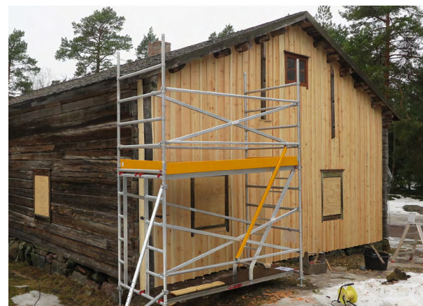
Kuva 7: Selkämän päärakennuksen ulkolaudoitusta tehdään Seurasaaressa
