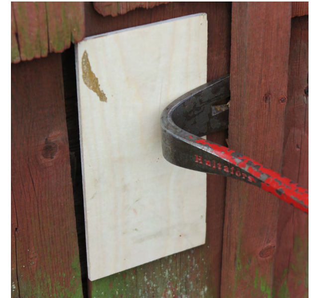
Kuva 14: Lahonneen laudan irrotus onnistuu parhaiten sorkkaraudan ja laudanpätkän avulla, jotta ehjään lautaan ei jää jälkiä.
