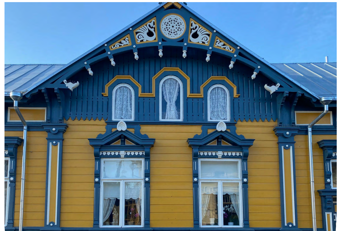
Kuva 5: 1800-luvulla suosittiin ulkovuorauksessa runsasta koristelua, jota vielä korostettiin erisävyisillä maaleilla, kuten tässä talossa Vanhassa Raumassa. Veistetty ja höylätty lauta on yleensä maalattu pellavaöljymaalilla.
