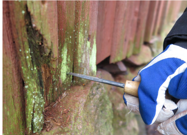
Kuva 8: Piikillä pistelemällä voi tutkia, onko laudoitus vain pinnaltaan pehmeä vai myös syvemmältä.
