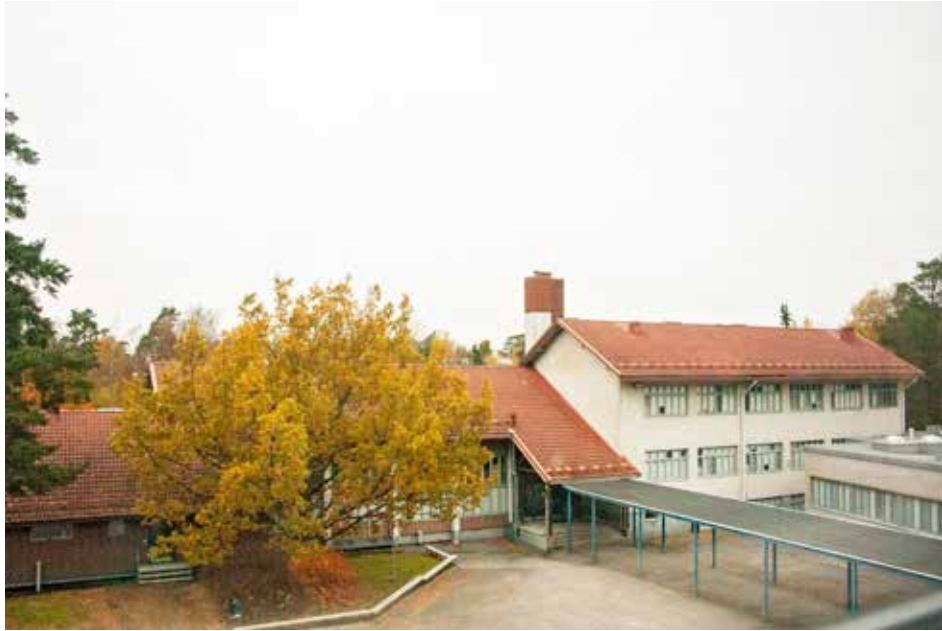
Viherlaakson koulun vanhimmassa osassa on kolme samansuuntaista siipeä, vasemmalta alkaen: asun- tosiipi, juhlasali ja luokkahuonesiipi. Kuva ark-byroo 2016.
