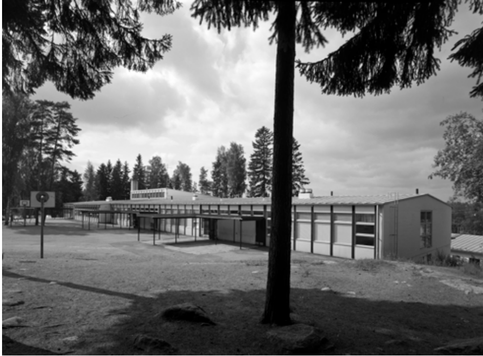
Hansakallion koulun julkisivussa on tuontu esiin käytettyä modulimitoitusta. EKM.
