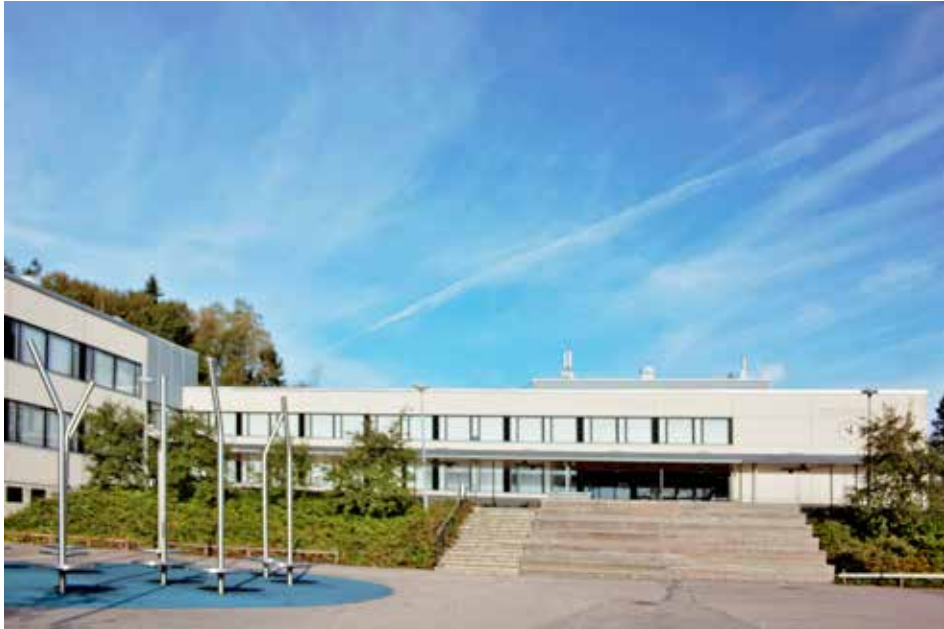
Espoon yhteislyseon koulun ja lukion julkisivuissa on käytetty betonielementtejä. Kuva ark-byroo 2016.
