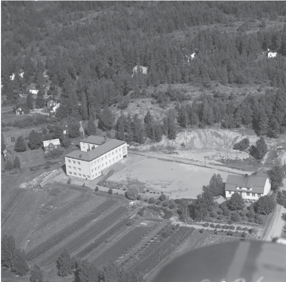
Leppävaaran koulu kuvattuna ilmasta vuonna 1958. Kuvassa näkyy koulun ensimmäinen laajennus, vanha puukoulu oikealla ja etualalla koulun hyötypuutarha. EKM.
