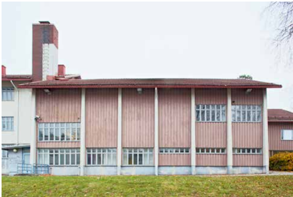
Juhlasaliin julkisivussa rytmittyvät rapatut teräsbetonirakenteet ja puurakenteiset seinän osat innovatiivisella tavalla. Kuva AK/ark-byroo 2016.
