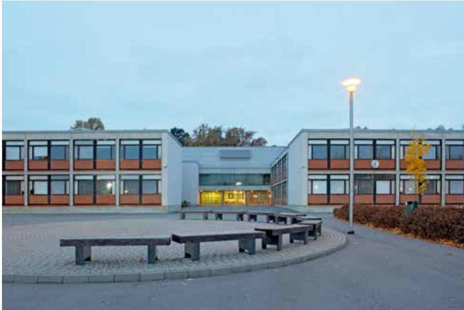
Kaitaan koulu ja lukio on peruskorjattu äskettäin. Uudistukset on tehty rakennuksen luonnetta kunnioittaen. Kuva AK/ark-byroo 2016.
