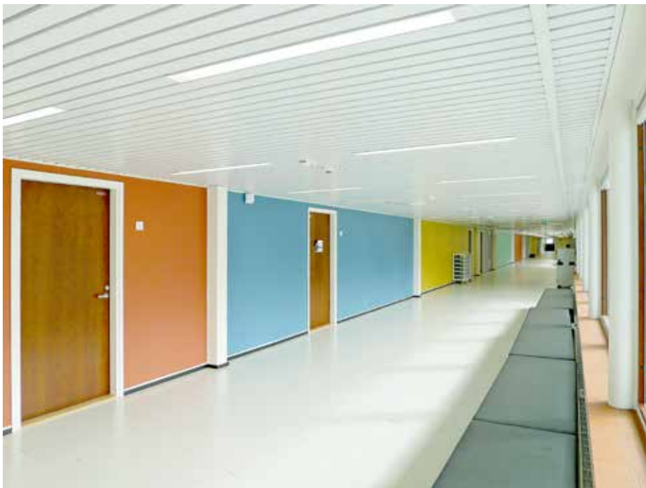
Tapiolan koulun ja lukion muutettuja sisätiloja. Korjauksen suunnittelijat ovat käyttäneet alkuperäistä suunnitelmaa lähtökohtana, mutta eivät ole pyrkineet säilyttämään sellaisenaan sisätiloja. Käytävää on levennetty, kun taas seinän alkuperäisiä värejä on palautettu. Kuva ark-byroo 2016.
