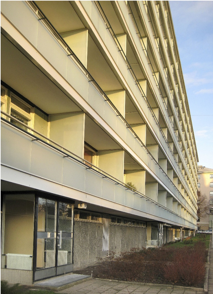
Lasipalatsiksi kutsuttu kahden tontin mittainen moderni kerrostalo Rauhankatu 19 (arkkitehti Olavi Laisaari) on Mikaelinkirkon taustana. Laisaari uskoi modernin muutoksen välttämättömyyteen. Kuva: Turun kaupunki Kaupunkisuunnittelutoimiala, Samuli Saarinen, 2007.
