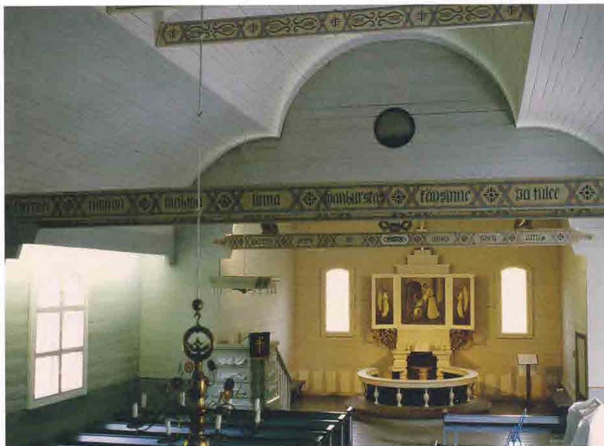
Kirkkosalissa on kolmiapilaholvaus ja tukipilarit sidehirsineen.
