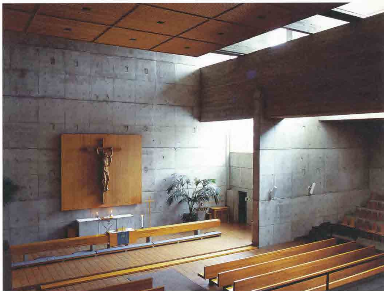
Kirkkosalin seinät ovat silkinhienoksi hierrettyä betonia.
