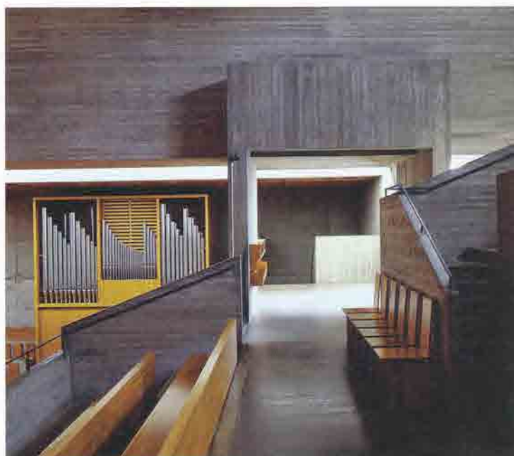
Lehterin seinissä näkyy muottilautojen jäljet.
