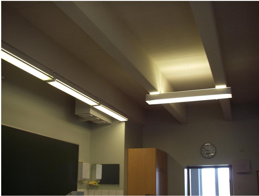
Lauttakylän lukio, 1958, B-osa. Ylälaattapalkisto-välipohjarakenteen tunnistaa katossa erottuvista palkeista. Kuva: TTY, Elinkaariteknikan tutkimusryhmä, kuntotutkimukset.
