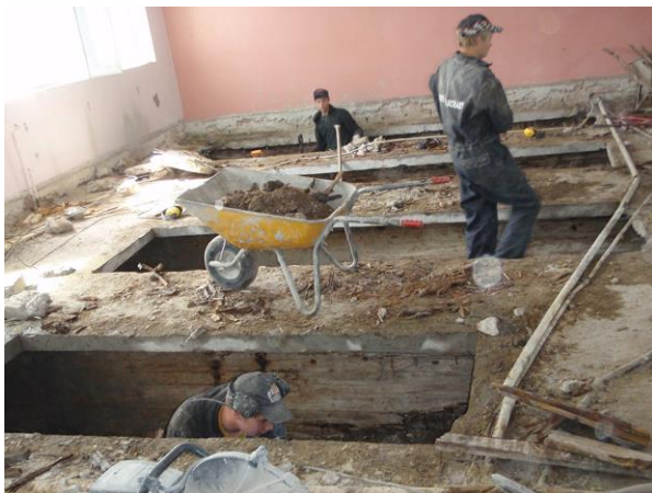
Vasemmalla muottilautoitusten purkaminen yläkautta. Tässä tapauksessa kantavan alapohjan ja pintalaatan välissä ollut Toja-levy poistettiin ja muottilaudat purettiin ylhäältä käsin. Oikealla muottilautoitusten purkaminen yläkautta. Alapohjan alla olevan ryömintätilan mataluuden takia vaurioituneisiin muottilautoihin päästiin käsiksi vain yläpuolelta. Kuvat: Rakennusinsinööri Jommi Suonketo.
