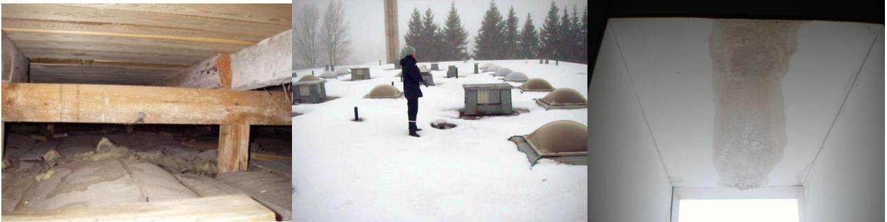
Kuvat vasemmalta oikealle: Pellonpuiston koulu, 1968, B-puoli, vesikaton alapuolinen tuuletustila. 1960-luvulla loivat katot toteutettiin usein puukorotuksina ja mineraalivillaeristeisinä. Tilan mataluuden takia tutkiminen ja korjaaminen vesikattovuodon jälkeen oli hyvin rajoitettua. Pellonpuiston koulu, 1968, B-puoli, vesikatto. Suhteellisen pienen koulurakennuksen katolla olleet 18 kupuikkunaa ja yhteensä 53 läpivientä olivat aiheuttaneet toistuvia vesivuotoja. Rieskalähteen koulu, 1963, kattoikkuna sisäpuolelta. Kattoikkunoiden vuotovauriot aiheuttavat helposti sisäilmahaittaa voimakkaan ilmankierron takia. Kuvat: TTY, Elinkaariteknikan tutkimusryhmä, kuntotutkimukset.
