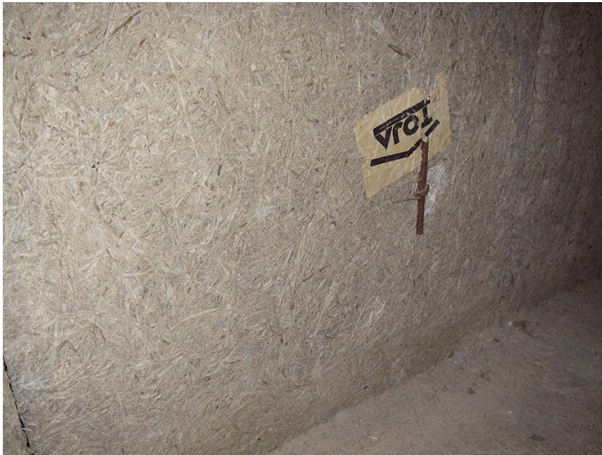
Lauttakylän lukio, 1960, väliosa, Toja-levy valumuottina. Sementtiveljistä ja puunlastusta tehtyä lastuvillalevyä (Toja-levy) käytettiin myös betonivalujen paikoilleen jätettävänä muotteina. Kuva: TTY, Elinkaariteknikan tutkimusryhmä, kuntotutkimukset.
