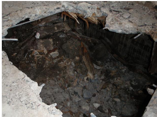
Vasemmalla muottilautoitusten purkaminen yläkautta. Tässä tapauksessa kantavan alapohjan ja pintalaatan välissä ollut Toja-levy poistettiin ja muottilaudat purettiin ylhäältä käsin. Oikealla muottilautoitusten purkaminen yläkautta. Alapohjan alla olevan ryömintätilan mataluuden takia vaurioituneisiin muottilautoihin päästiin käsiksi vain yläpuolelta. Kuvat: Rakennusinsinööri Jommi Suonketo.
