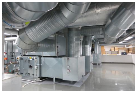
Vasemmalla Martinlaakson koulun uusi kattokonehuone. Kuva: Jukka Sainio. Keskellä uusi konehuone louhittiin koulun aiempaan käyttämättömään alustatilaan. Kuva: Jukka Sainio. Oikealla uuden konehuoneen kanavoinnit valopihalla. Kuva: Sari Nieminen.
