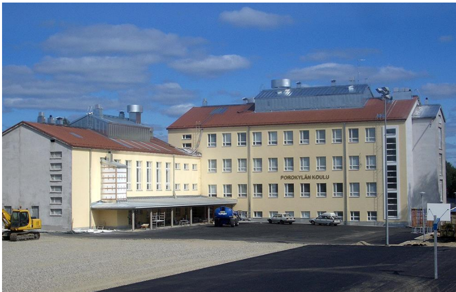
Nurmeksen Porokylän koulun ullakoille eivät konehuoneet mahtuneet ilman vesikaton korotuksia. Kuva: Jukka Sainio.
