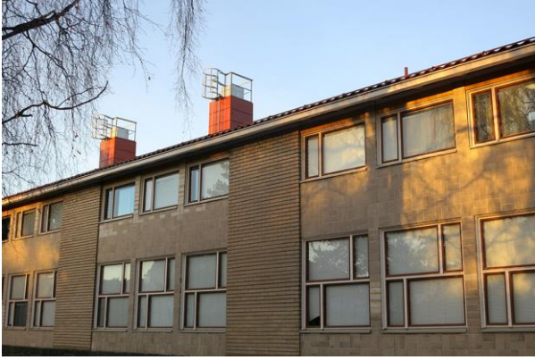
Vasemmalla Hertsikan ala-asteen koulun poistoilmapiiput lämmöntalteenottolaitteineen. Oikealla koteloidut runkokanavat Hertsikan ala-asteen luokkakäytävällä. Kuvat: Jukka Sainio.
