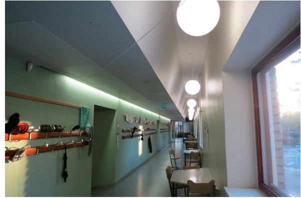
Vasemmalla Hertsikan ala-asteen koulun poistoilmapiiput lämmöntalteenottolaitteineen. Oikealla koteloidut runkokanavat Hertsikan ala-asteen luokkakäytävällä. Kuvat: Jukka Sainio.
