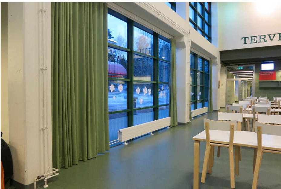
Martinlaakson koulun peruskorjauksessa uusittiin myös pattereita. Kuva: Jukka Sainio.
