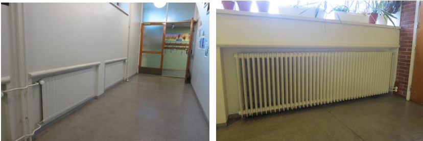
Kuvat vasemmalta oikealle: Patterit asennettiin syvennyksiin Herttoniemen kansakoulussa (nyk. Hertsikan ala-aste, Ahmatien koulu) vuonna 1952. Komea alkuperäinen patteri Hertsikan ala-asteen aulan portaikossa. Kesto-radiaattorit, Yleisluettelo 1952. Valokuvat: Jukka Sainio.
