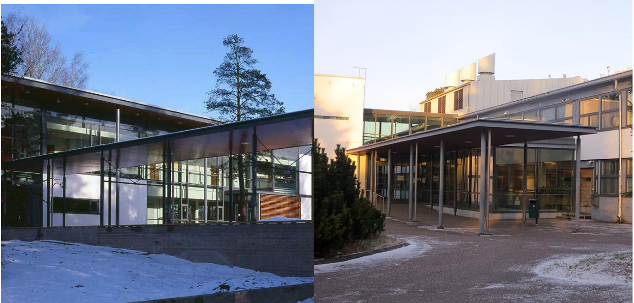
Vasemmalla Herttoniemen yhteiskoulu, 1957, arkkitehdit Erik Kråkström ja Ahti Korhonen. Laajennus ja peruskorjaus vuodelta 2001, Arkkitehtiryhmä A6 Oy. Kuva: Jukka Sainio. Oikealla peruskorjauksen yhteydessä vesikatolle rakennetut runkohanavat ja konehuone vesikatolla. Kuva: A6 Oy.
