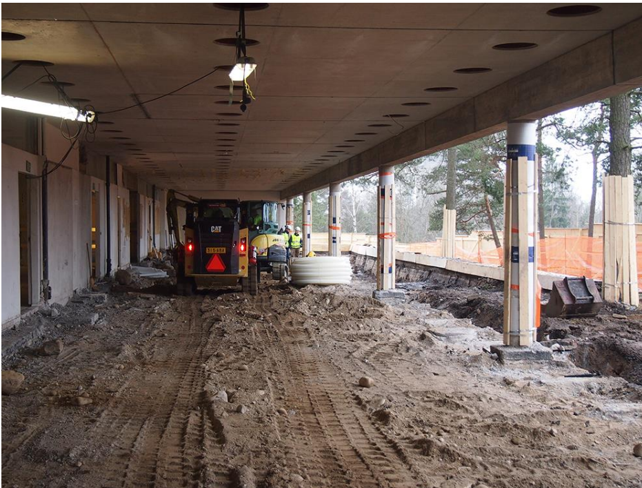
Roihuvuoren koulun ulkoseinä- ja alapohjarakenteet uusittiin. Säilyvät rakennusosat ja puusto suojattiin huolellisesti, paitsi alakatot, jotka nekin säilyivät vahingoittumattomana työmaan ajan. Kuva: Mikko Lindqvist, Helsingin kaupunginmuseo.
