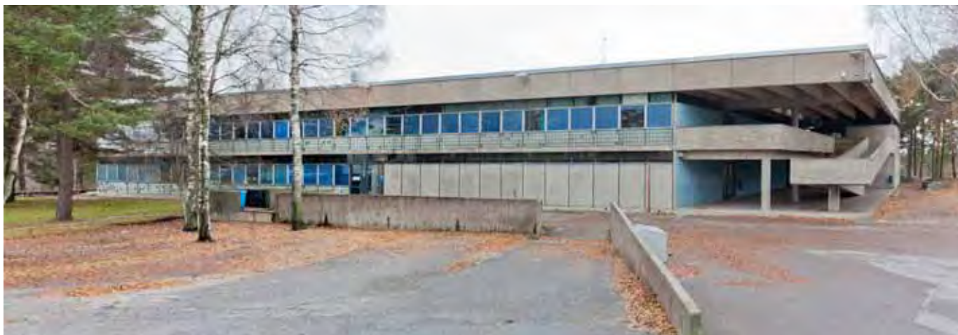
Pohjoispään katos, sen alle sijoittuva parveke kävelyluiskineen sekä sokkeli muodostavat rakennuksen pohjoispäähän täsmällisesti rajautuvan tilan. Itäjulkisivulla on liikuntavälinevaraston ja pukuhuoneiden kohdalla betonielementtiseinää, muilta osin siinä on laajat ikkunapinnat.
