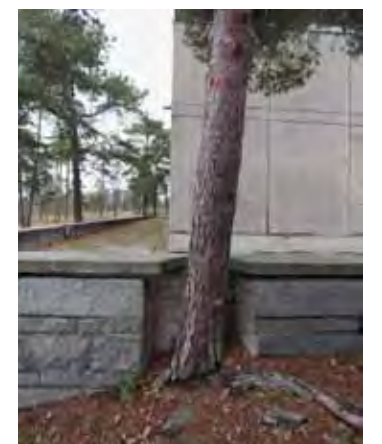
Puuta varten tehty syvennys tukimuurissa
