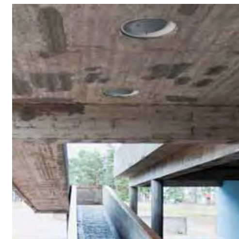
Katoksen parvekkeen alapinnan valaisimia ja betonipinnassa olevia paikkauksia.
