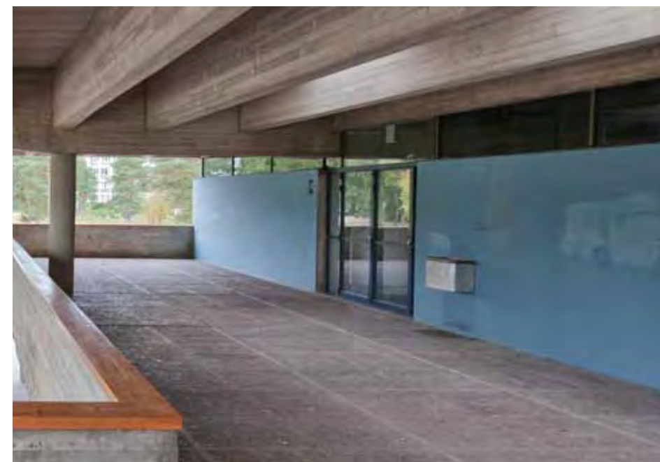
Paikallavalettua seinää pohjoispään katoksen toisessa kerroksessa.
