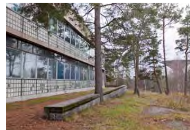
Betoninen tukimuuri joka on verhoiltu rinteen puolelta luonnokivin.
