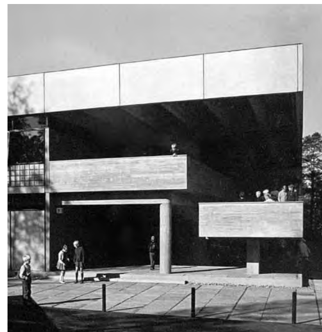
Rakennuksen koillisnurkka 1960-luvulla. Räystääspellit erottuu kuvasta juuri ja juuri. Kuva: Arkkitehtuurimuseo / Simo Rista.
