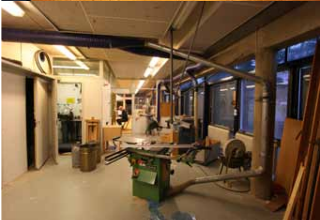
Purunpoistolaitteiston putkia puutyökone tilassa (168–169).
