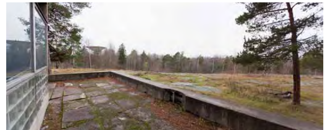
Laatoitusta länsijulkisivun eteläpäässä vuonna 2013.
