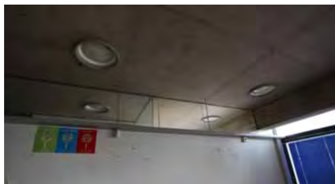
Alkuperäisiä puhtaaksivalettuja betonialakattoja opettajien tiloissa (104 kirjasto ja kerhotila). Valaisimet on uusittu.
