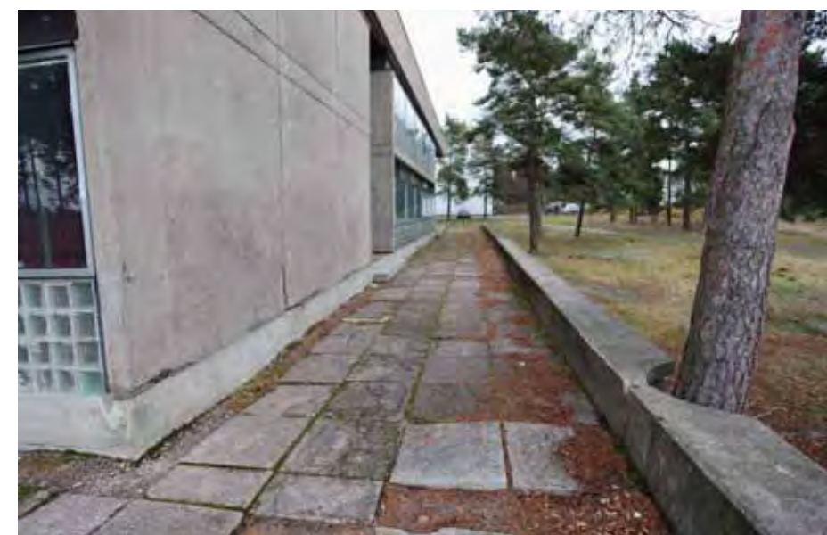
Rakennuksen eteläisivun laatoitusta. Huomaa puuta varten tehty syvennys betonimuurissa.
