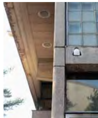
Pinta-asennuksiin on tehty pieniä muutoksia täälläkin julkisivulla.
