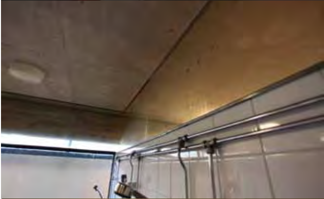
Suihkuhuoneiden ilman- vaihtoa on parannettu jo rakennusvaiheessa teke- mällä ylälaseihin reikiä.
