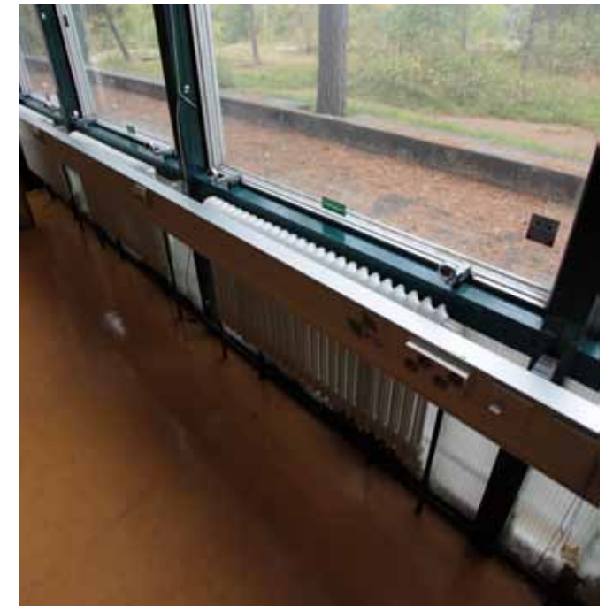
Ikkunaseinien edssä olevat alumiinikourut on tehty sähköremontin yhteydessä.
