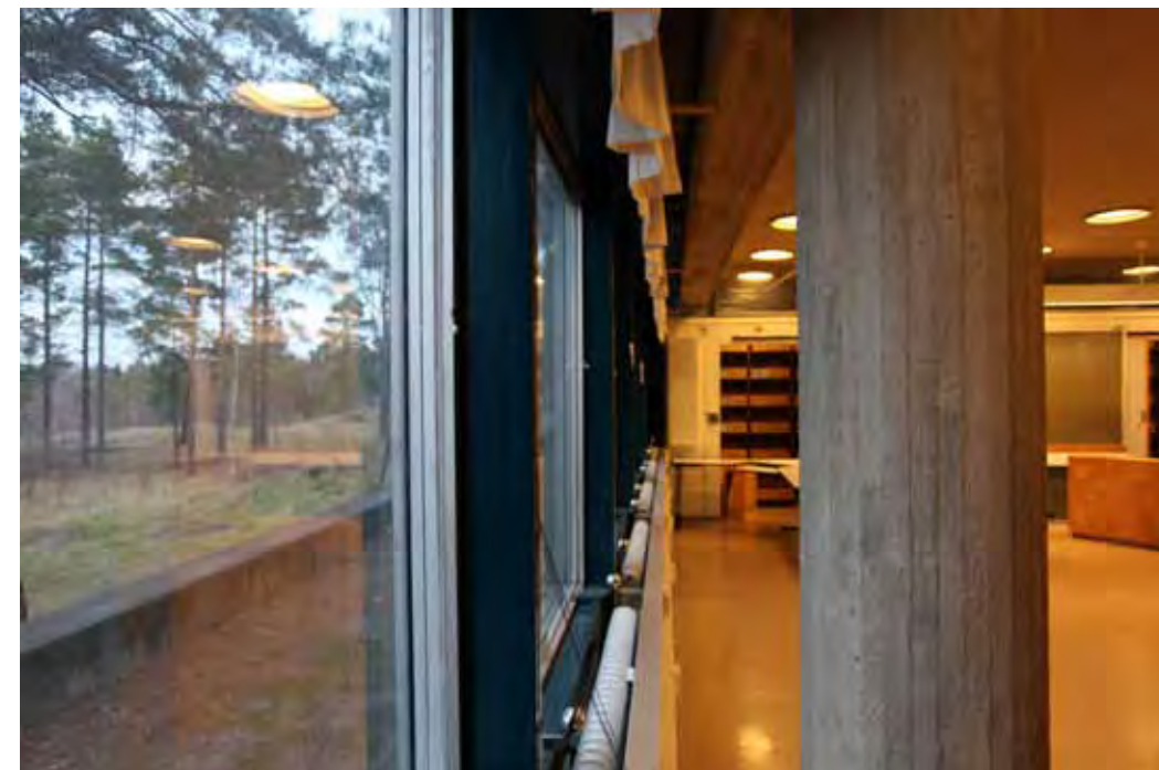
Uloin pilaririvi näkyy ensimmäisen kerroksen ikkunaseinien vieressä. Toisessa kerroksessa pilareita ei ole.
