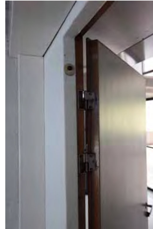
Saranallisten puuvien karmit on kiinnitetty suoraan betoniseinään.
