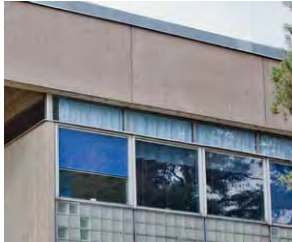
Nauhaikkunan puukarmien vaihtuminen metallisiin julkisivun eteläosassa (tila 226).
