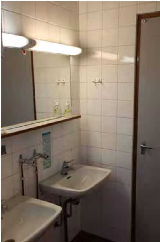
Pesutilan (162) kalusteista osa on uusittu. Peili ja lavuaarit ovat luultavasti alkuperäisiä.
