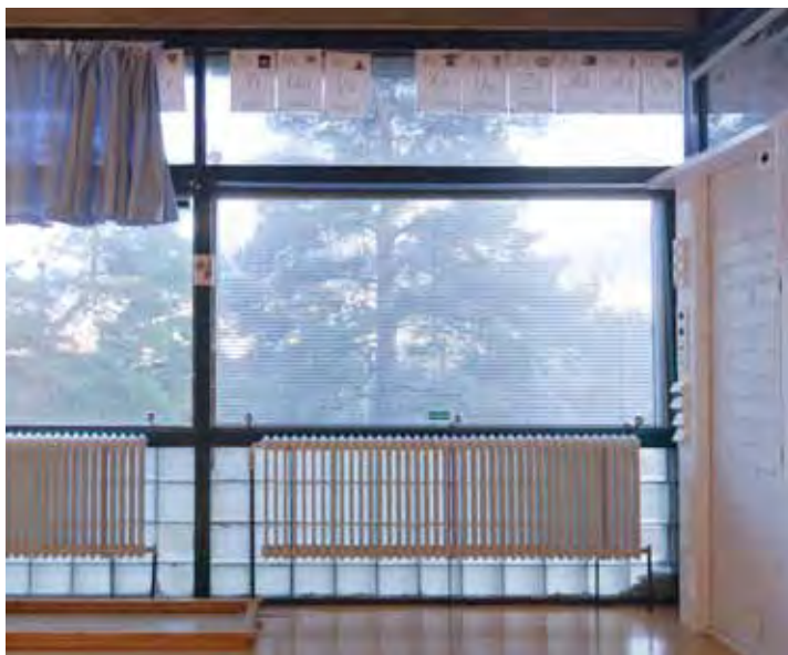
Eteläjulkisivun leveä ikkunamitoitus sisältä nähtynä.
