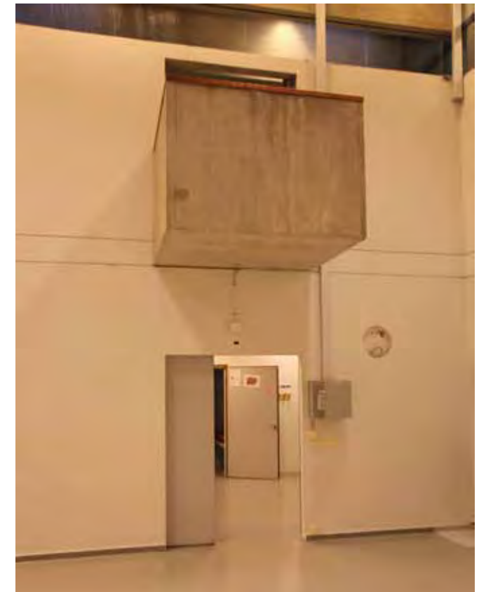
Toisen kerroksen hallista (213) juhlasaliin avautuva betoniparveke.
