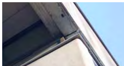
Yläkerran nauhaikkunan pellitystä alhaalta nähtynä. Työpiirustuksen 115 mukaan (ks. alla) pellitys on alun perin suunniteltu noudattamaan betoniseinän muotoa.
