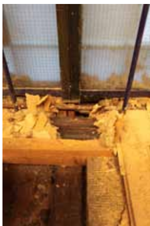
Teknisen työn luokan (166) lattiaan tehdystä avauksesta näkee, että lämpöputket kulkevat julkisivun myötäisesti.
