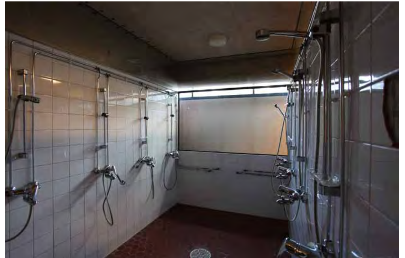
Pesuhuoneisiin saadaan luonnonvaloa suuren sisäikkunan kautta.
