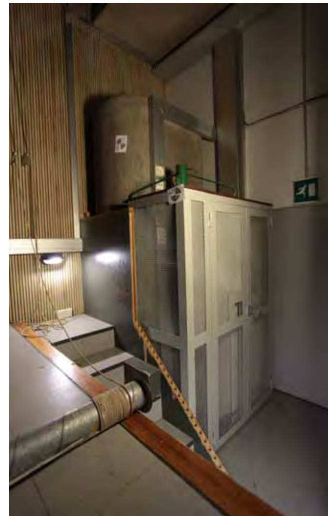
Betoninen tuloilmarakenne näyttämön sivutilassa (128).
