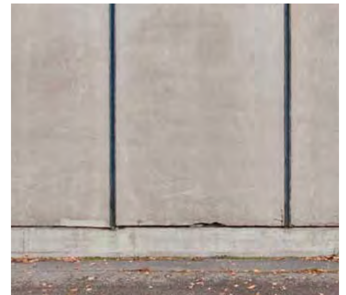
Pukuhuoneen kohdalla olevan elementiseinän alaosa (itäjulkisivu). Elementtien väliin on asennettu vastaavalla tavalla U-teräkset kuin lasitiilikenttien väliin.
