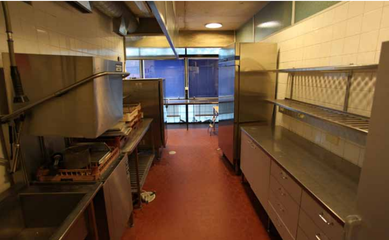
Jakelukeittiön (164) seinät ja lattiat on laatoitettu.
