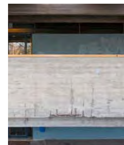
Katoksen parvekkeen alapinnan valaisimia ja betonipinnassa olevia paikkauksia.
