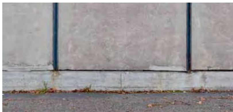
Pukuhuoneiden kohdalla olevien betonielementtien alaosien paikkauksia.
