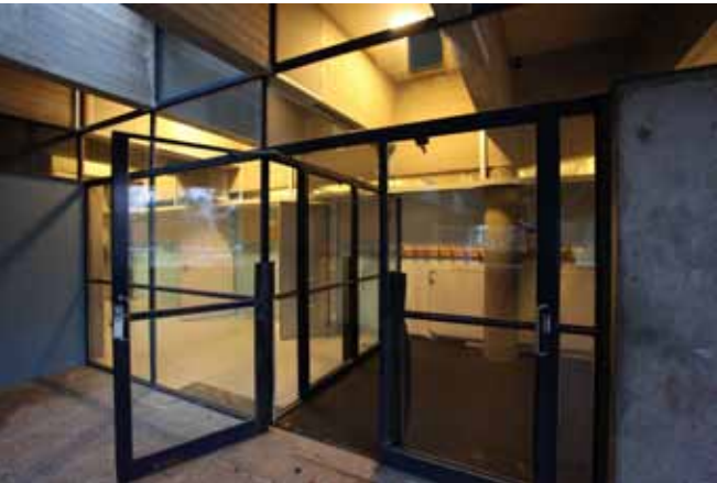
Tuulikaapit ovat teräs-lasirakenteisia.
