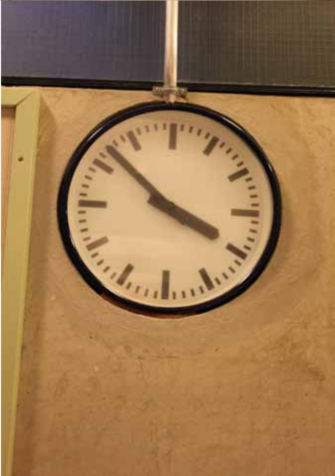
Upotettu kello ruokalan seinässä on oletettavasti alkuperäinen, vaikka joh- dotus onkin uusittu.
