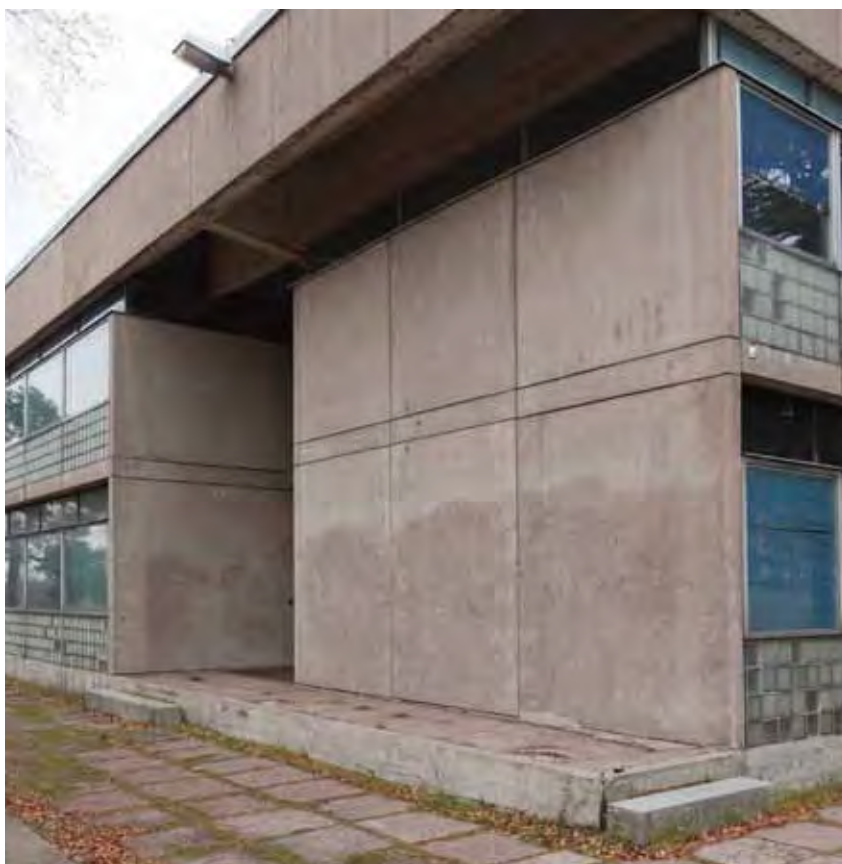
Elementtiseinää eteläjulkisivulla.
