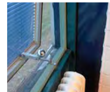
Ikkunaremontin yhteydessä uudet ikkunat asennettiin vanhoihin karmeihin. Alkuperäiset helat, tyyppiä ‘M/Mome’, siirrettiin uusiin ikkunoihin.
