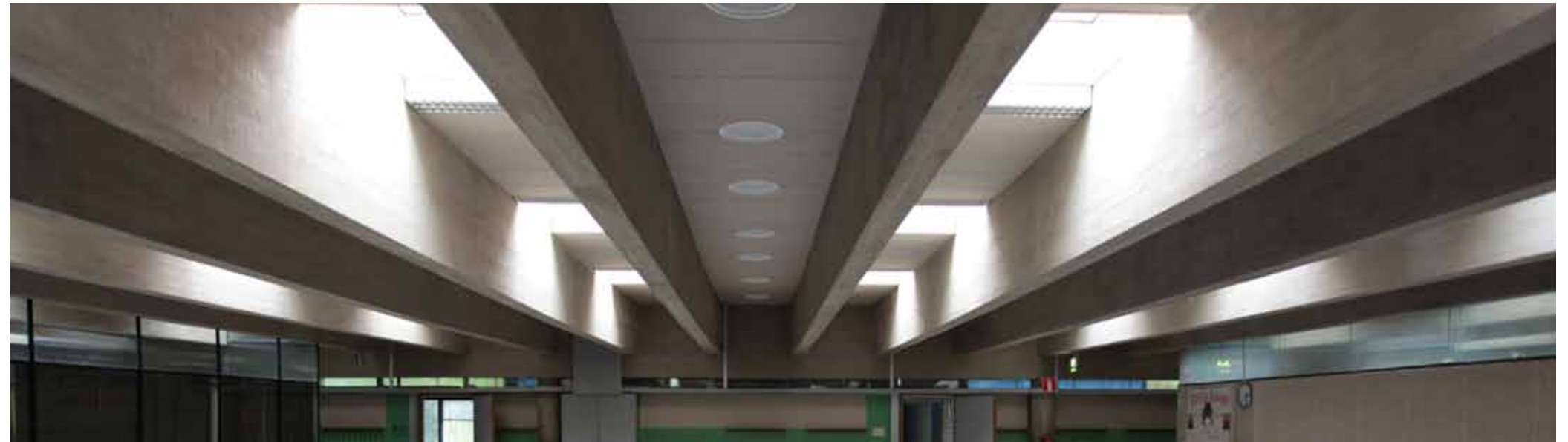
Kantavat rakenteet ovat näyttävästi esillä varsinkin toisen kerroksen katossa.
