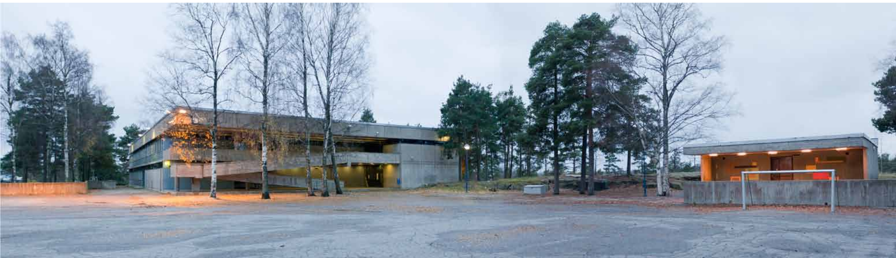
Koulu nähtynä piha-alueen yli pohjoisen suunnasta. Julksivun otsapintaan kiinnitety valonheittimet ovat myöhempiä asennuksia. Oikealla välituntipihan WC-rakennus.
