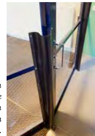
Oven saranapuolelle jälkikäteen asennettua kumimattoa.
