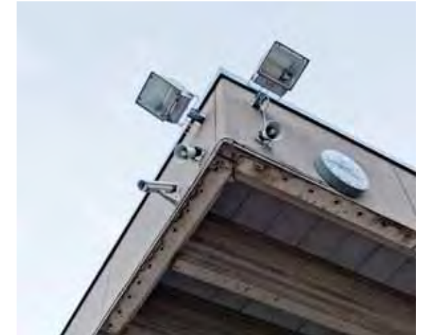
Räystäään otsapintaan on asennettu valonheittäjiä, kovaäänisiä ja valvontakameroita. Myös (pohjoisjulkisivun puolella oleva) viisarikello on tässä kohdassa myöhempi asennus. Alun perin kello on sijainnut katoksen alla olevassa seinässä.
