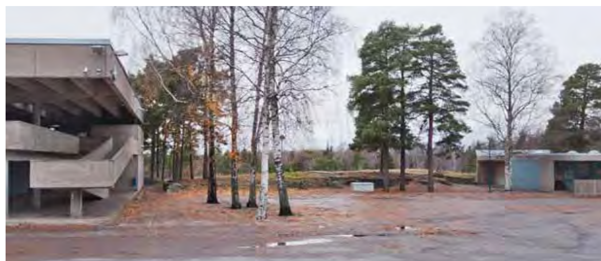
Koulurakennuksen ja pihan käymälärakennuksen väliin on jätetty näkymä taustan maisemaan.
