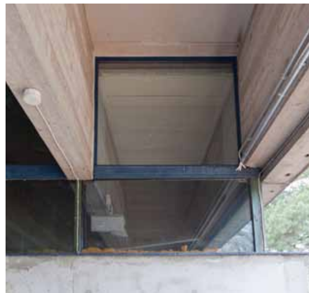
Katoksen alle jäävän betoniseinän, yläikkunavyöhykkeen ja kattorakenteen liittyminen toisiinsa. Huomaa ikkunakarmien artikulointi: rakennuksen ympäri jatkuvassa nauhaikkunassa on vihreät puukarmit, niiden yläpuolella, rakenteisiin integroituna, on siniset teräskarmit.
