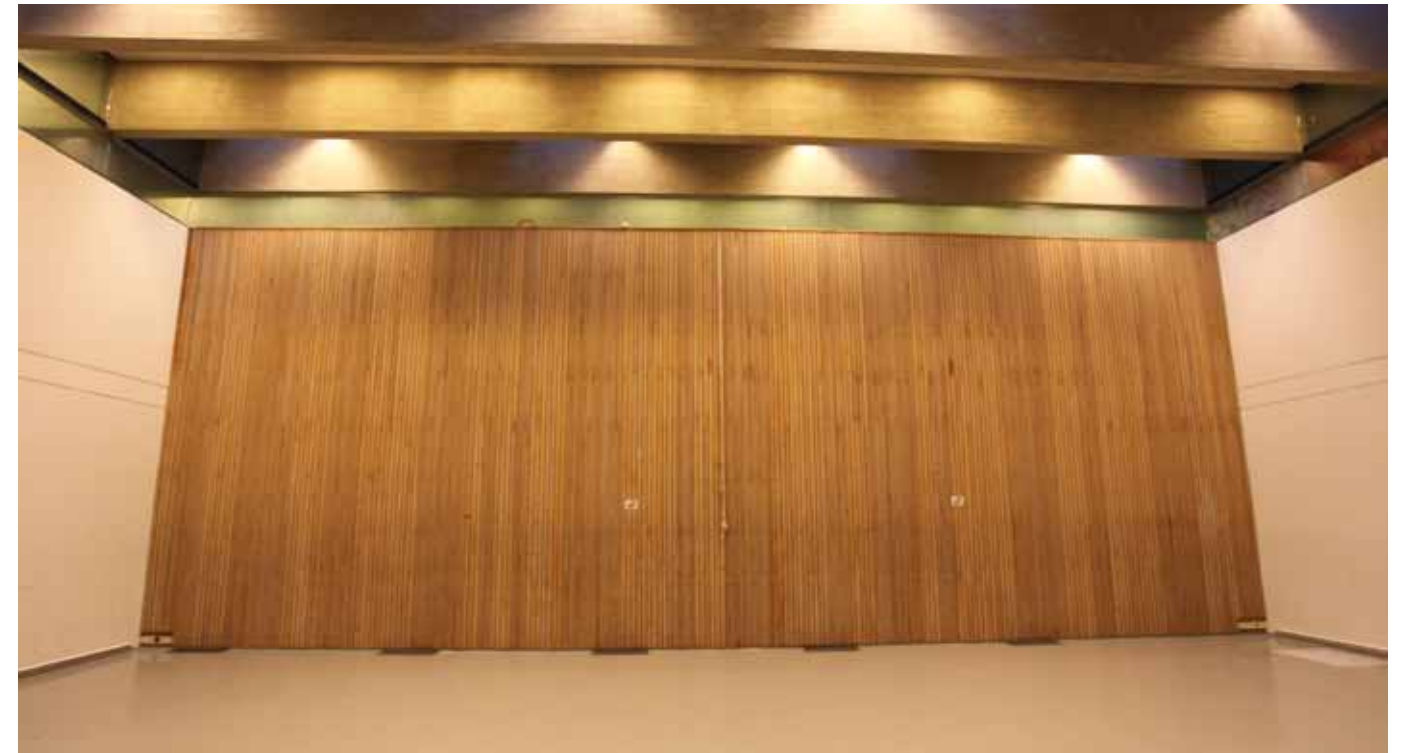
Juhlasalin (132) puuseinä on alkuperäinen rakennusosa. Seinän alalaidassa näkyvät koneellisen korvausilman ritilät.
