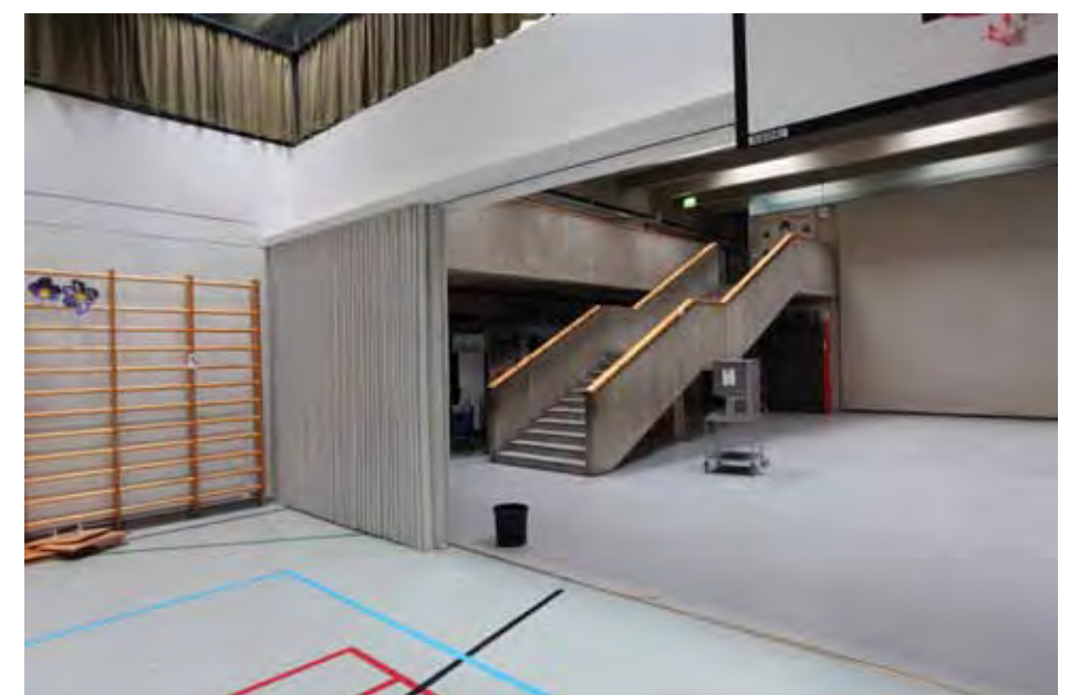
Paljeovi erottaa liikuntasalin ja ruokalan toisistaan.
