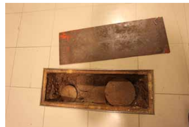
Ilmanvaihtoputkien huoltoluukku käytävässä 147.
