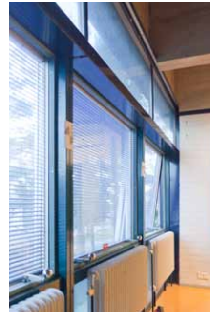
Ikkunaremontin yhteydessä uudet ikkunat asennettiin vanhoihin karmeihin. Alkuperäiset helat, tyyppiä ‘M/Mome’, siirrettiin uusiin ikkunoihin.
