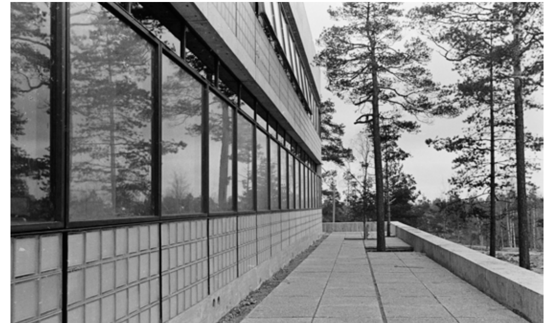
Laattakäytävä, tukimuuri ja puustoa länsijulkisivun eteläpäässä vuonna 1967. Kuva: Suomen valokuvataiteen museo / Matti Saanio.
