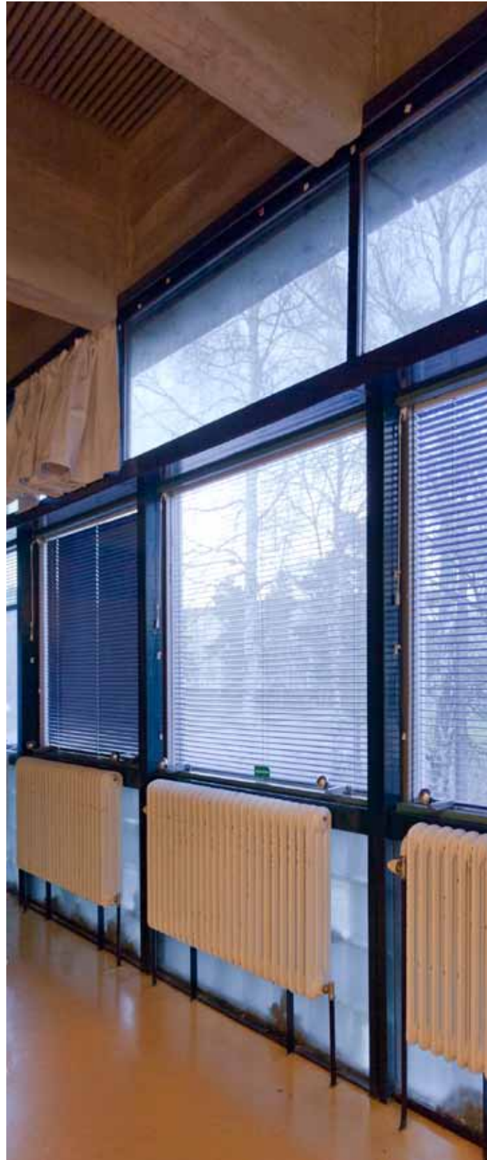
Itäjulkisivun ikkunaseinää toisessa kerroksessa sisäpuolelta nähtynä.
