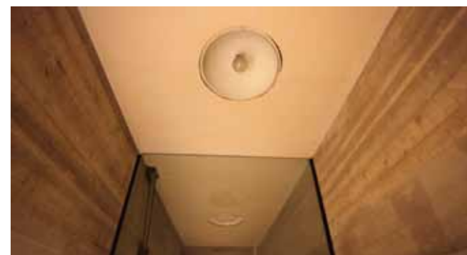
Akustiikkalevyillä peitettyä Siporex-alakattoa näyttämön yläosassa (127). Alkuperäinen valaisin on säilynyt.
