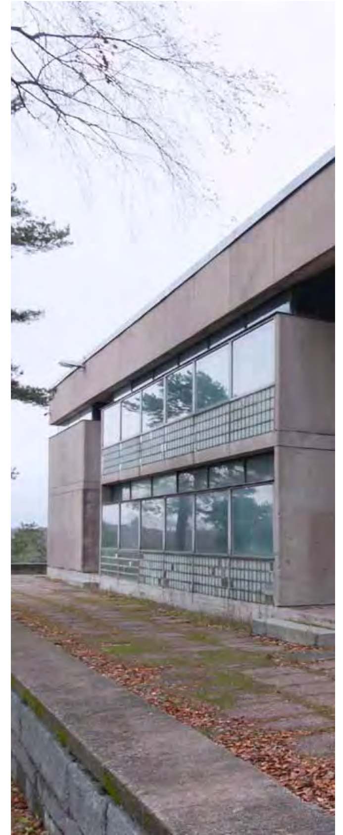
Eteläjulkisivun edustalla on kauttaaltaan jäljellä alkupe- räistä betonilaatoitusta.
