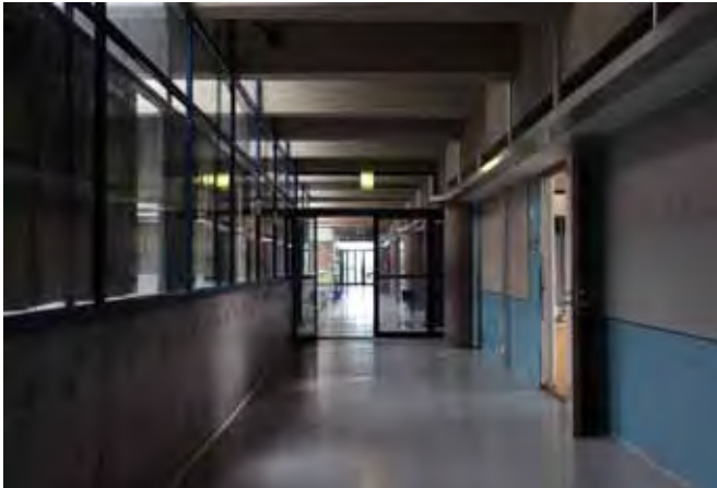
Käytävä 218 on jaettu teräs-lasiovella vuonna 1996.
