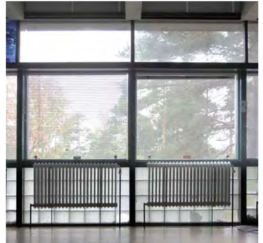
Länsijulkisivun ikkunaseinää toisessa kerroksessa.
