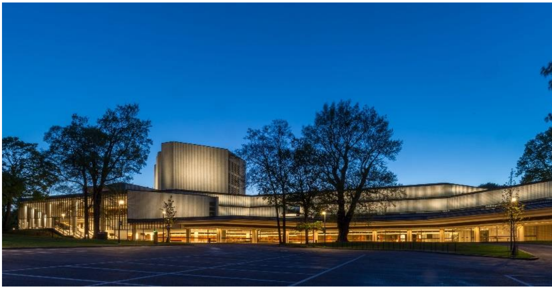
Ulko- ja julkisivuvalaistus uusittiin kokonaan lukuun ottamatta ulkokatosten upotettuja valaisimia, jotka kunnostettiin. Kuvassa julkisivuvalaistuskokeita syysiltana. Kuva: LPR-arkkitehdit Oy 2017.
