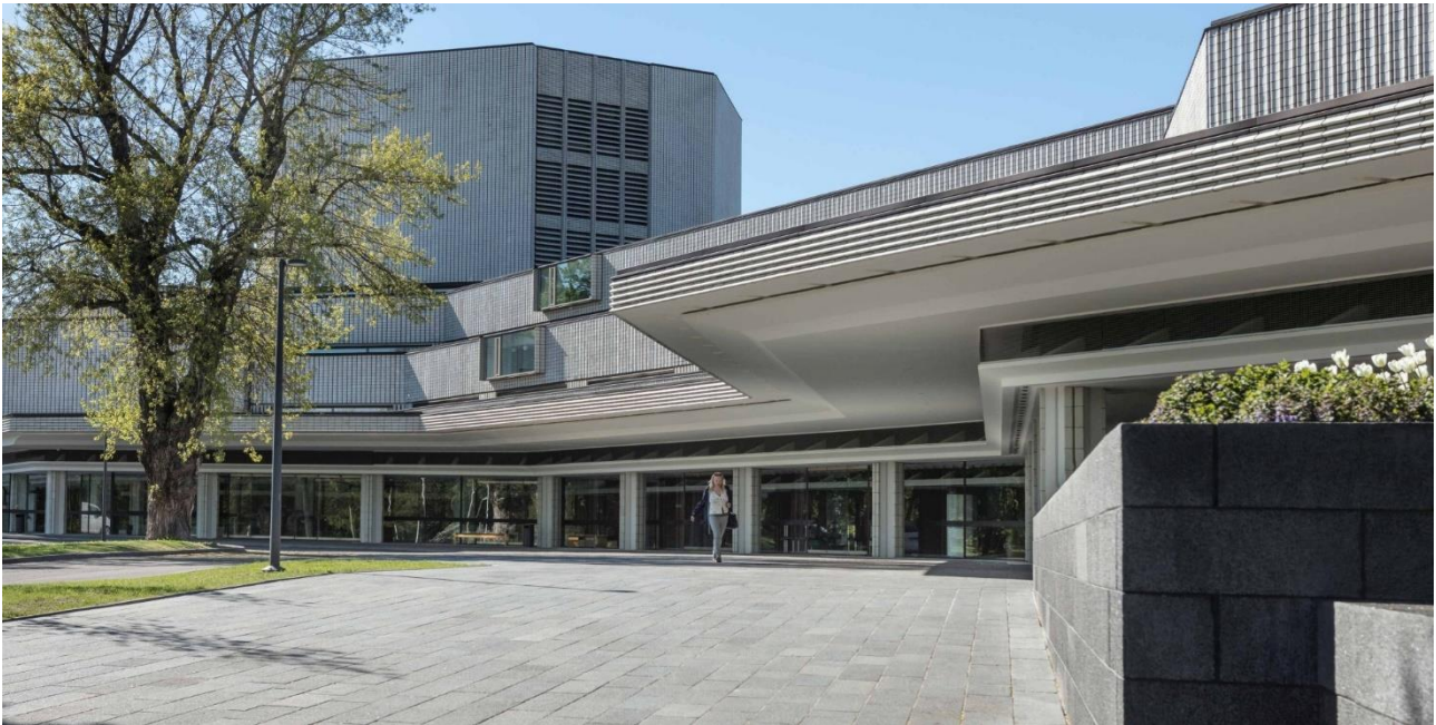
Kaupunginteatterin sisääntuloalue kunnostettuna. Kuva: Arno de la Chapelle 2017, LPR-arkkitehdit Oy.
