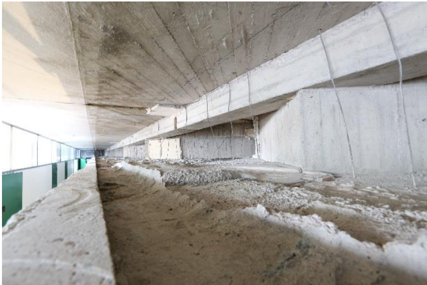
Vas.: Henkilökuntatilojen käytävässä betonialakaton otsapinta on avattu ilmanvaihtokanavien asentamista varten. Kuvassa alakaton sisus. Sekä välipohjan että alakaton betoni on vinolautamuotitettu. Kuva: LPR-arkkitehdit Oy 2016. Oik.: Alakaton otsapinta levytettynä. Kuva: Sirkkaliisa Jetsonen 2019.
