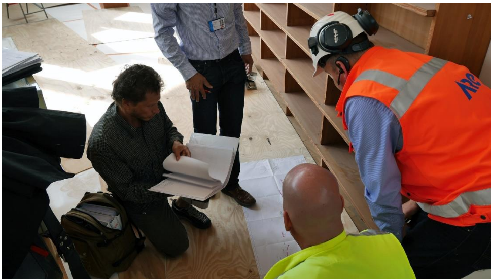
Työmaalla tapahtuva valvonta ja ohjaus on restauroinnissa keskeisessä osassa. Kuva: Tapani Mustonen, 2014.
