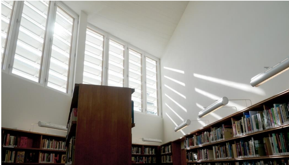
Kirjaston pääsalin yläikkunat etelään on suojattu leveällä metallisäleiköllä. Kuva: Olli Helasvuo, 2015.
