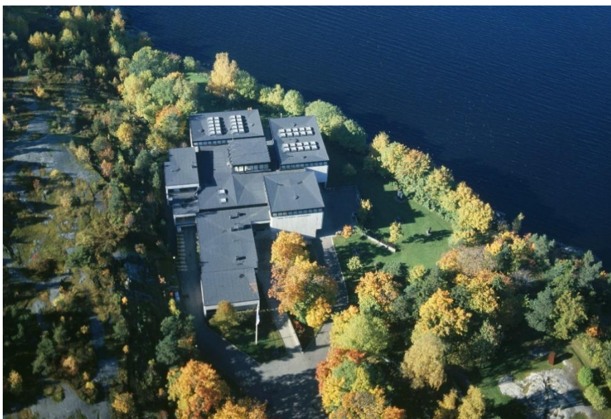
Sara Hildénin taidemuseon (1979) sisääntulokerroksen keskellä on valokatollinen huone, jonka ympärille ryhmittyvät muut salit nauha- ja kattoikkunoineen. Pohjakaava on neliapila eli ydin ja satelliitit -mallia. Kuva: Teuvo Kanerva, Museovirasto.
