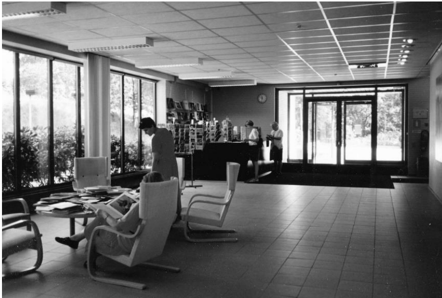
Helsingin kaupungin taidemuseon uudisrakennus valmistui 1976. Sisääntuloaulan iso ikkuna avautuu Meilahden kartanon puistoon. Kuva: Marja-Liisa Rönkkö
