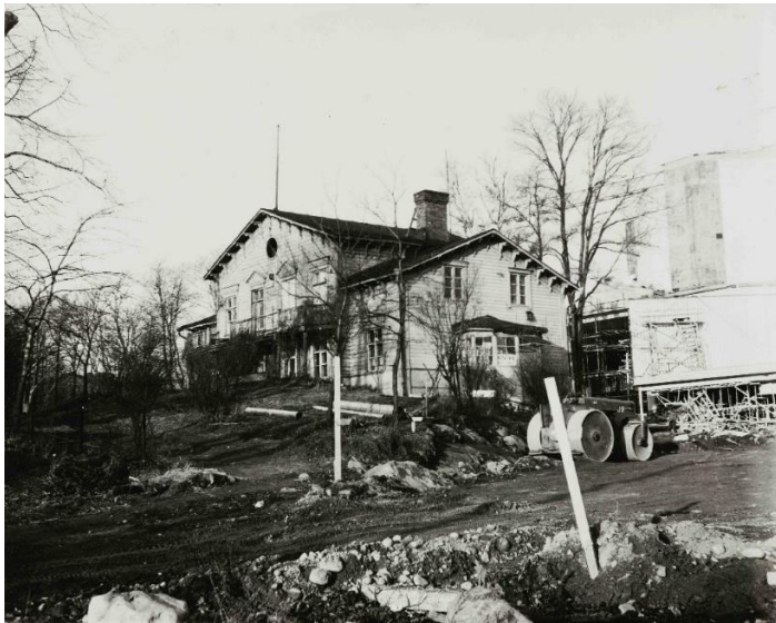
Eläintarhan huvila nro 4. Taustalla kaupunginteatterin rakennustyömaa noin 1966. Kuva: Aulis Ryyppö, Museovirasto.
