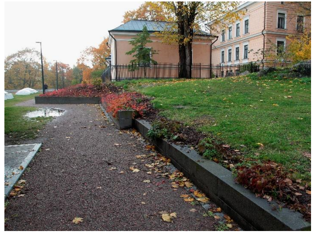
Vas.: Tilanne Studio Elsan pohjoispuolella ennen peruskorjausta. Kuva: Gretel Hemgård 2014. Oik.: Uusi tukimuuri Studio Elsan pohjoispuolella tontin rajalla. Hulevesiä valuu edelleen viheralueelta kannelle. Kuva: Gretel Hemgård 2019.
