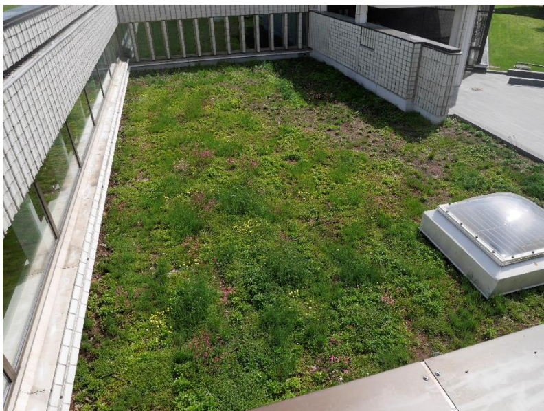
Kukkiva katto päälämpöön länsipäässä. Kuva: Tiina Taipale 2018.
