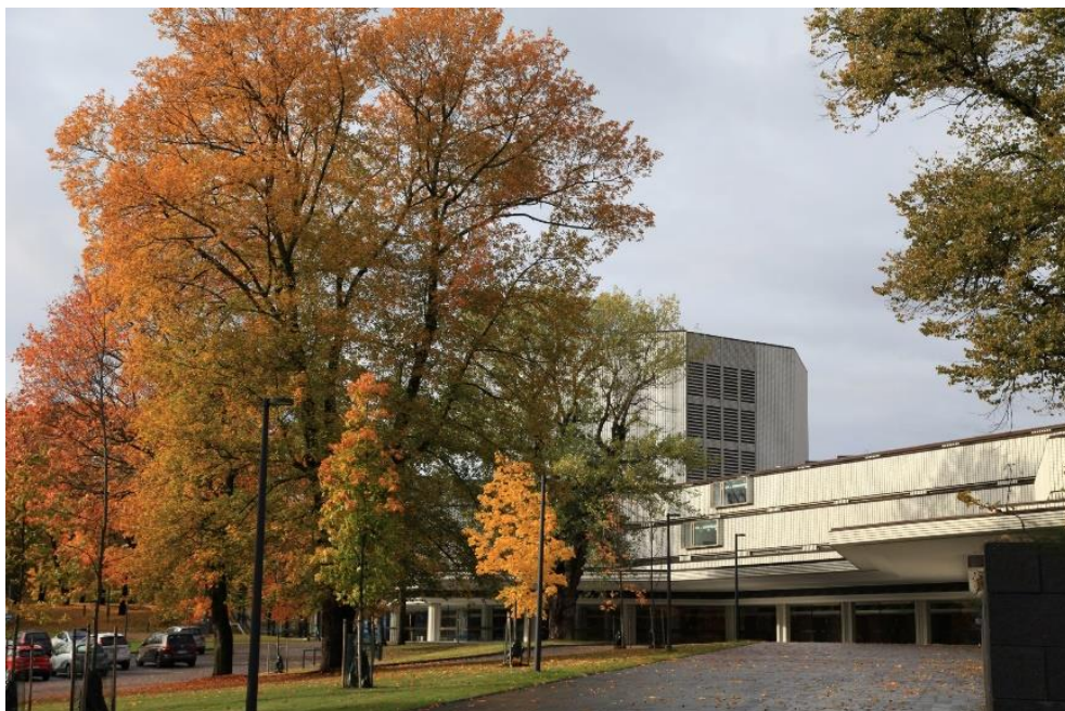
Lämpöön julkisivu näkyy pääkäytävälle puiden runkojen lomitse. Vanhat, julkisivua ja näkymiä peittäneet kuuset poistettiin. Kuva: Gretel Hemgård 2019.
