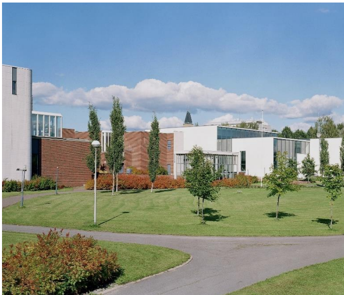
Kuusankoski-talon eteläjulkisivu, vasemmalla konserttisali. Kuva: Jussi Tiainen, Arkkitehtitoimisto Brunow & Maunula.
