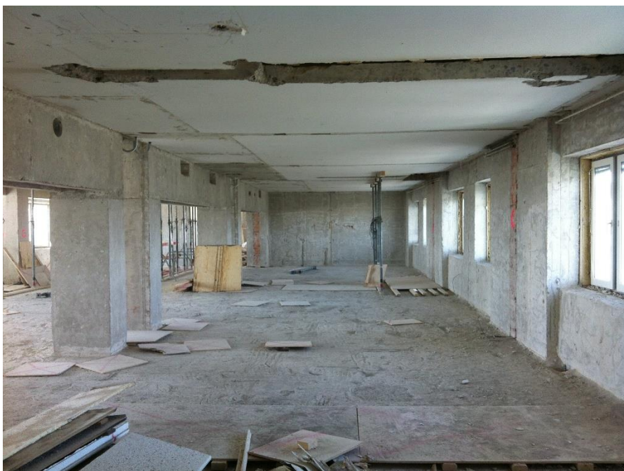
Sisätilat purkutöiden ollessa loppusuoralla. Kuva: Arkkitehtitoimisto SARC Oy.
