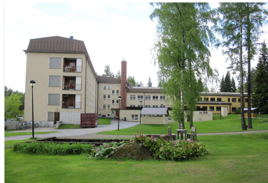
Kuva: Jyväskylän Kangasvuoren sairaalan (1958, kaup.arkkit. Olavi Kivimaa) vanha vinkkeliosa ja 1980-luvun laajennusosa. Sairaalarakennusta laajennettiin ensimmäisen kerran 60-luvulla ja viimeksi 1991. / Keski-Suomen museon valokuvakokoelma, Anna-Leena Lehto 2010.
