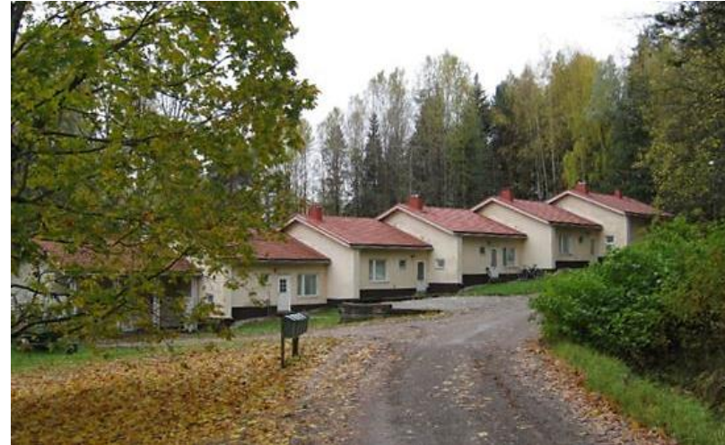
Kuva: Perheellisten tiilestä muurattu, rapattu rivitalo Lohjan Paloniemen sairaalan alueella. Valmistunut 1959 (arkkitehdit Kai Blomstedt ja Birger Stenbäck). Ketjumaisessa rinnetalossa noin 52 m 2 asunnot ovat limittäin sijoitetut. Vastaavalla tavalla rinneratkaisuna toteutettuja rivi- tai kerrostaloja on muillakin B-sairaala-alueilla. /Katariina Ockenström 2008, Lohjan kaupunkisuunnittelukeskus.
