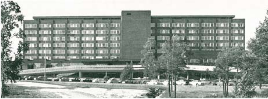
Kymenlaakson (Kotka, Veli ja Jaakko Paatela, 1967) keskussairaalan länsijulkisivu. Kantavat pilarit ulkonevat julkisivusta ja rytmittävät ikkunanauhoja. Maantasoa hallitsee ajoramppi. Kuva ARK 1/1971.
