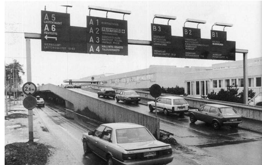
Oulun yliopistollisessa keskussairaalassa (Reino Koivula, 1973) autoliikenne ohjataan klinikkoiden sisäänkäynneille ramppia pitkin. Ramppi on näkyvä elementti ulkoarkkitehtuurissa. Rampin alla sijaitsee osa sairaalan auto- ja pyöräpaikoista.
