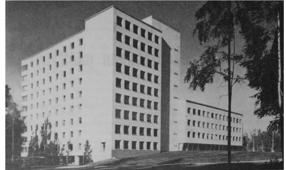
Erkki ja Inkeri Linnasalmen suunnittelema Vaasan keskussairaala rakennettiin 1952–1956. Kuva Sairaala 2/1960.
