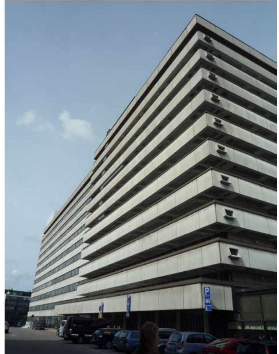
Turun yliopistollisen keskussairaalan U-sairaalan (Martta ja Ragnar Ypyä, 1968) julkisivut ovat linjakkaita nauhaikkunajulkisivuja. Etelä- ja länsisivujen parvekevyöhyke lisää julkisivun syvyyshaikutelmaa. Kuva Terhi Lehtimäki
