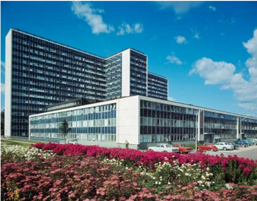
Helsingin keskussairaalan (Jaakko Paatela ja Reino Koivula, 1965) päärakennuksen julkisivu-materiaalina olivat alunperin alumiinilistoin kiinnitetyt julkisivulasit ja asbestisementtilevyt. Etualalla laboratorio- ja opetustiloja sisältävä osa, taustalla 15-kerroksinen vuodeosastotorni. Kuva Museovirasto.
