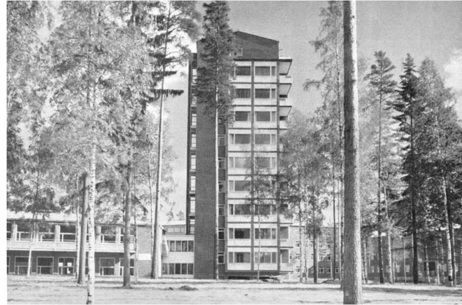
Keski-Suomen keskussairaala Jyväskylässä valmistui 1954, arkkitehtinä Jonas Cedercreutz ja Helge Railo. Kuvassa keittiösiiven ja vuodeosastotornin länsijulkisivua. Kuva ARK 4/1955.
