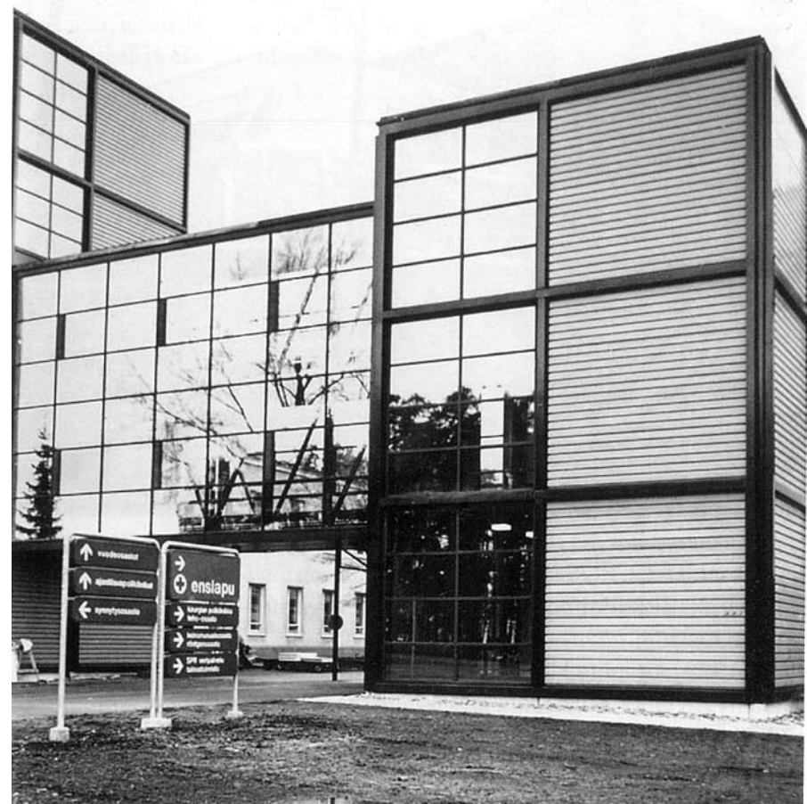
Satakunnan keskussairaalan (Pori, Veijo Martikainen, 1977) ensiapu- ja toimenpidetiloja sisältävä K-osa liittyy vanhaan kantasairaalaan. Nivelosien ja porrashuoneiden julkisivut ovat poimuohutlevypintaisia teräselementtejä. Leikkaus ARK 3/1975, kuva Aarne Seppälän kirjasta Potilaan parhaaksi.
