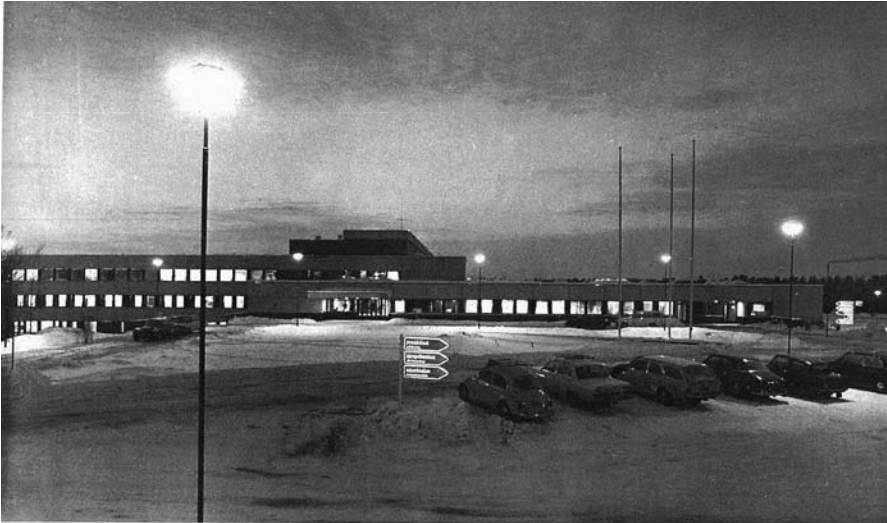
Keski-Pohjanmaan keskussairaala pääsisäänkäynnin suunnasta. Veijo Martikaisen ja Erkki Helaman suunnittelema sairaala valmistui Kokkolaan 1969. Kuva ARK 1/1971.
