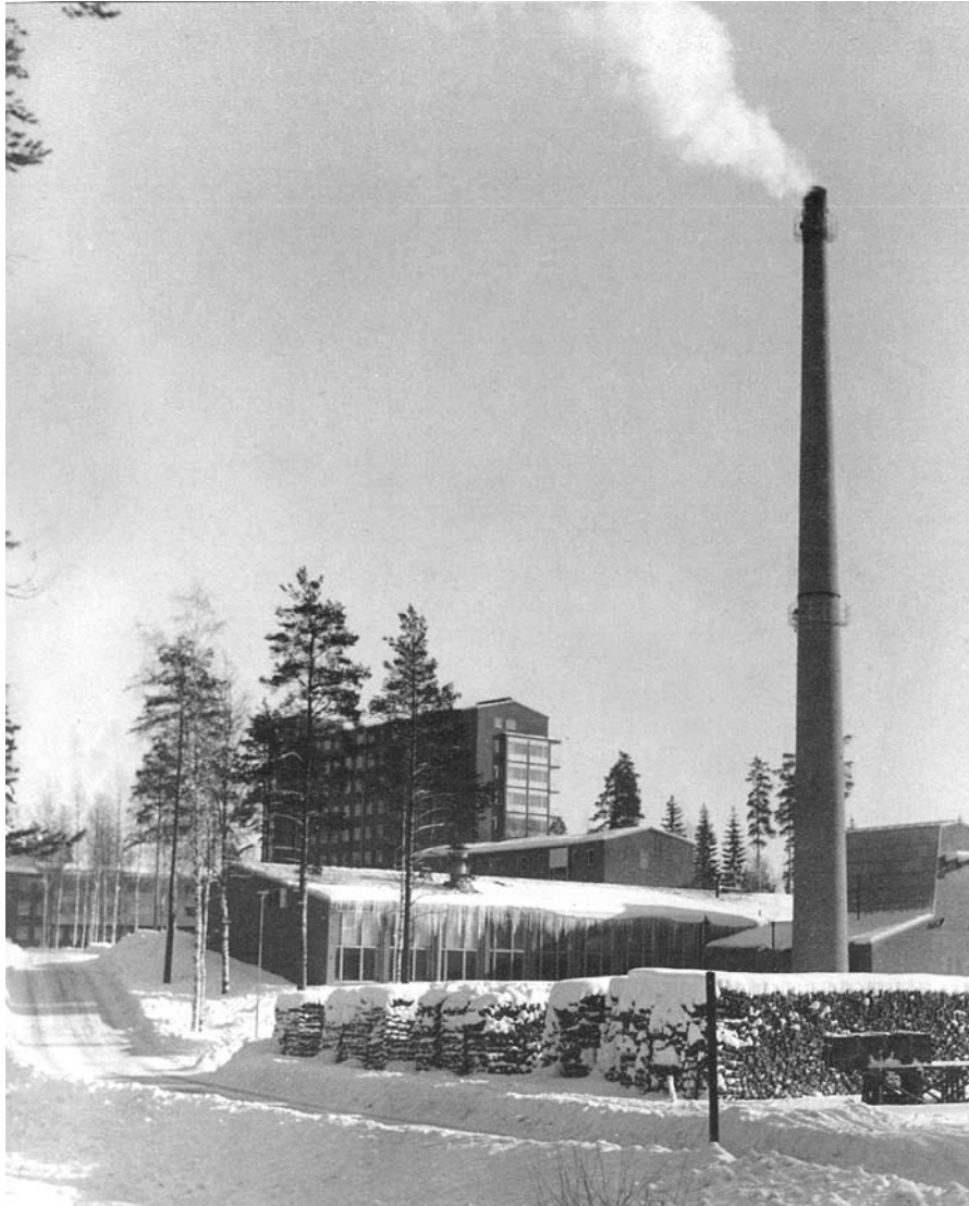
Keski-Suomen keskussairaalan (Jyväskylä, Jonas Cedercreutz ja Helge Railo, 1954) lämpökeskus 1950-luvulla, etualalla halkopinot. Kuva Eeva Stoltin kirjasta työ tekijäänsä kouluttaa.
