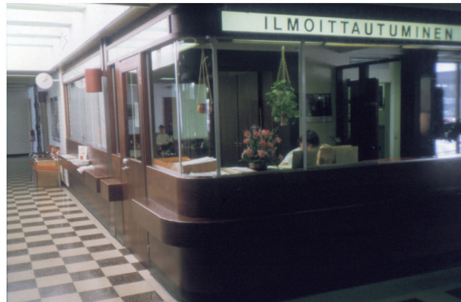
Veikko Voutilaisen suunnittelema Liedon Härkätien terveysaseman vanhin osa valmistui vuonna 1978 ja hoivaosasto vuonna 1989. Kuvat Helinä Kotilainen.
