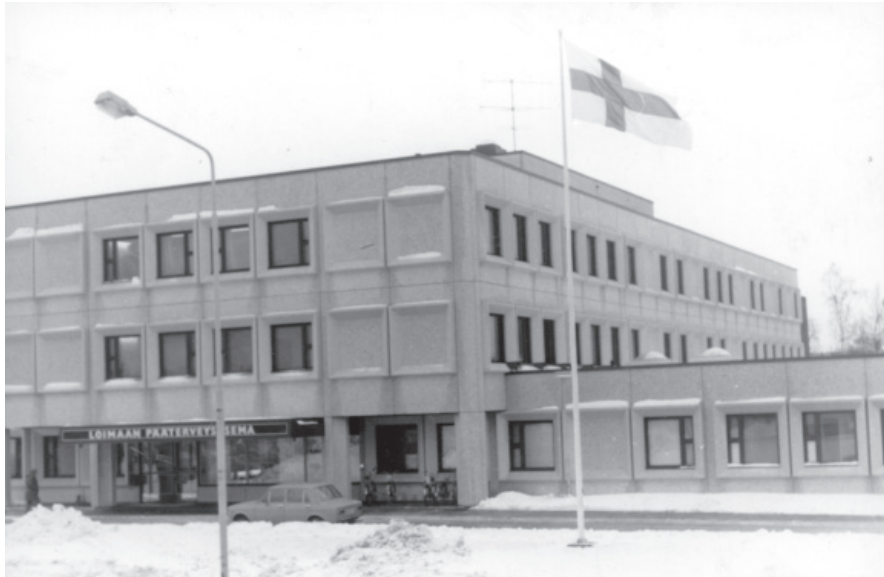
Loimaan pääterveysaseman julkisivuissa näkyy sekä strukturalismin että myös brutalismin piirteitä. Rakennuksen on suunnitellut Antti Karvonen ja se on valmistunut vuonna 1979. Kuva vuodelta 1983, Heikki Pihan postikorttikokoelma.
