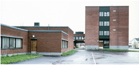
Ylivieskan 1970 valmistunut ja vuoteen 1978 mennessä laajennettu virastotalo. Ylivieska oli Keski-Pohjanmaan piiriorganisaatioiden sijoituspaikka ja sen virastotalo oli ollut 1960-luvun kiireellisyysjärjestyksen kärjessä. Kuva: Härö, Museoviraston Kuvakokoelmat.
